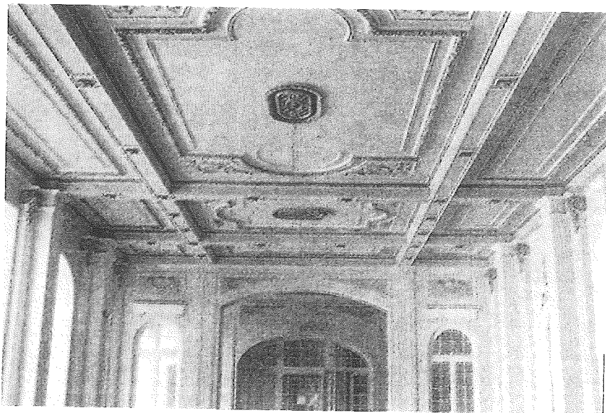
Detalle del techo, 1987.
