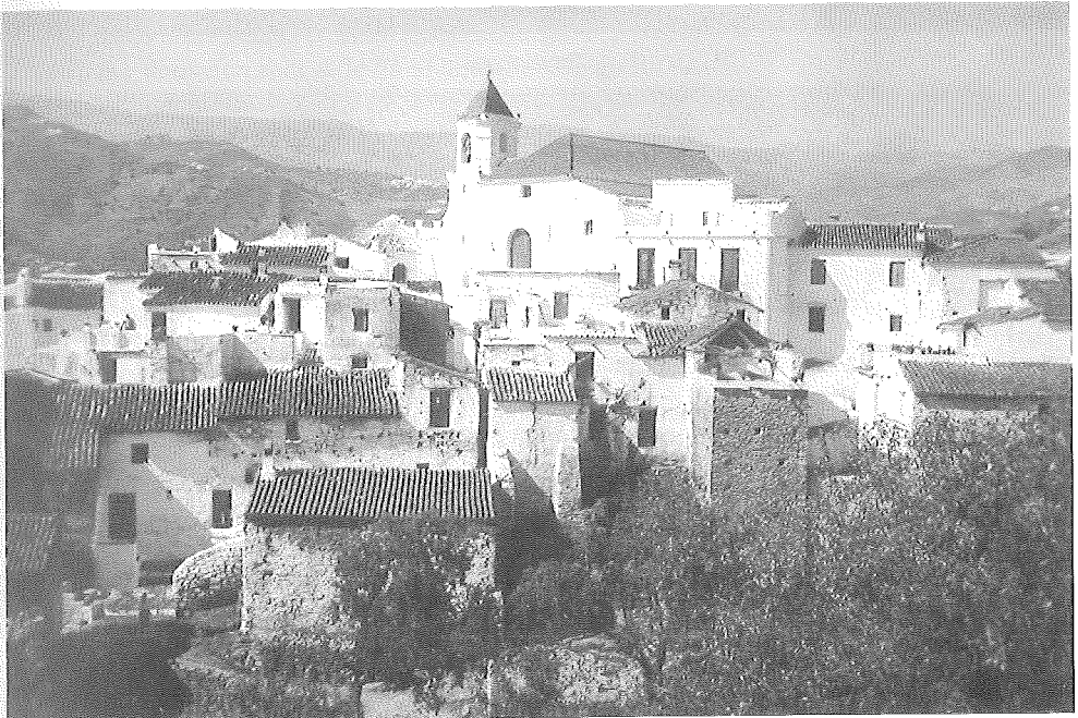
Sayalonga. Se observa un torreón medieval del recinto (Años 1950-1960). Foto: Archivo Temboury.
