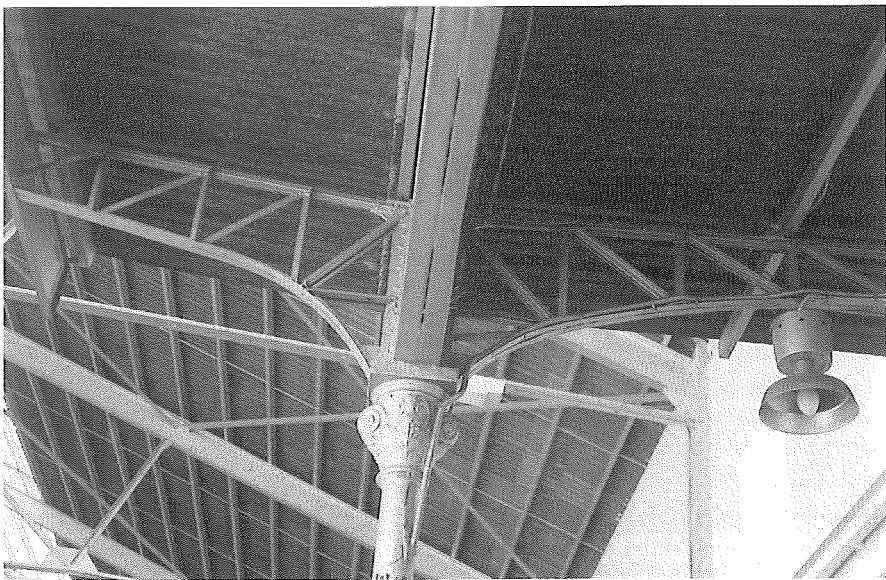
Detalle de la estructura metálica en el interior. (Foto: R. Marín)
