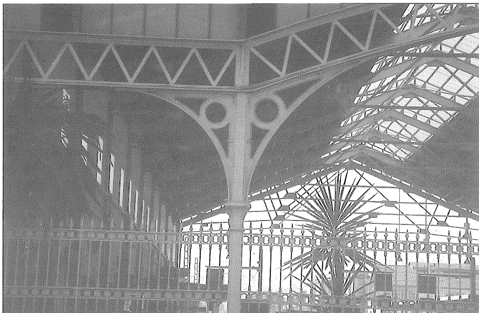
Marquesina metálica de la Estación de FF.CC. Detalle. (Foto: R. Marín)
