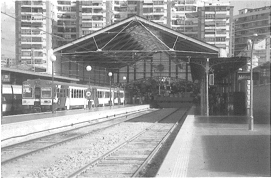
Marquesina de la estación vista desde los andenes. (Foto: R. Marín)
