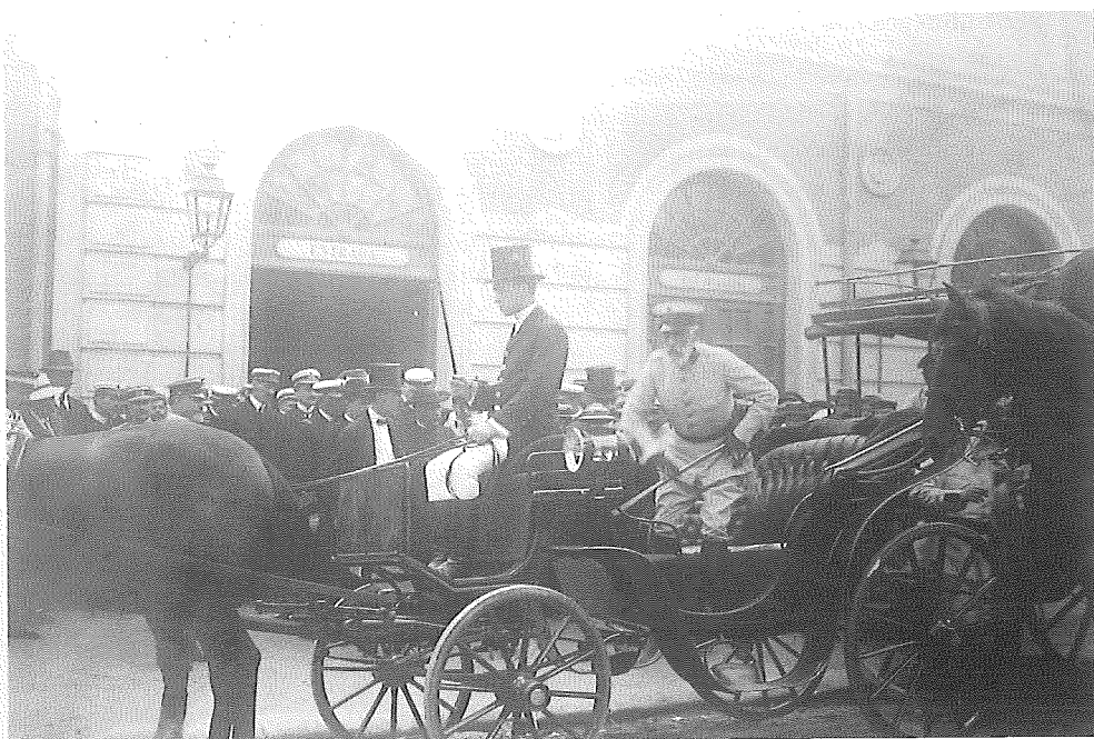
Imagen histórica. El Capitán General de Sevilla a su llegada a la estación (h. 1900. A.D.E. Fundación UNICAJA)
