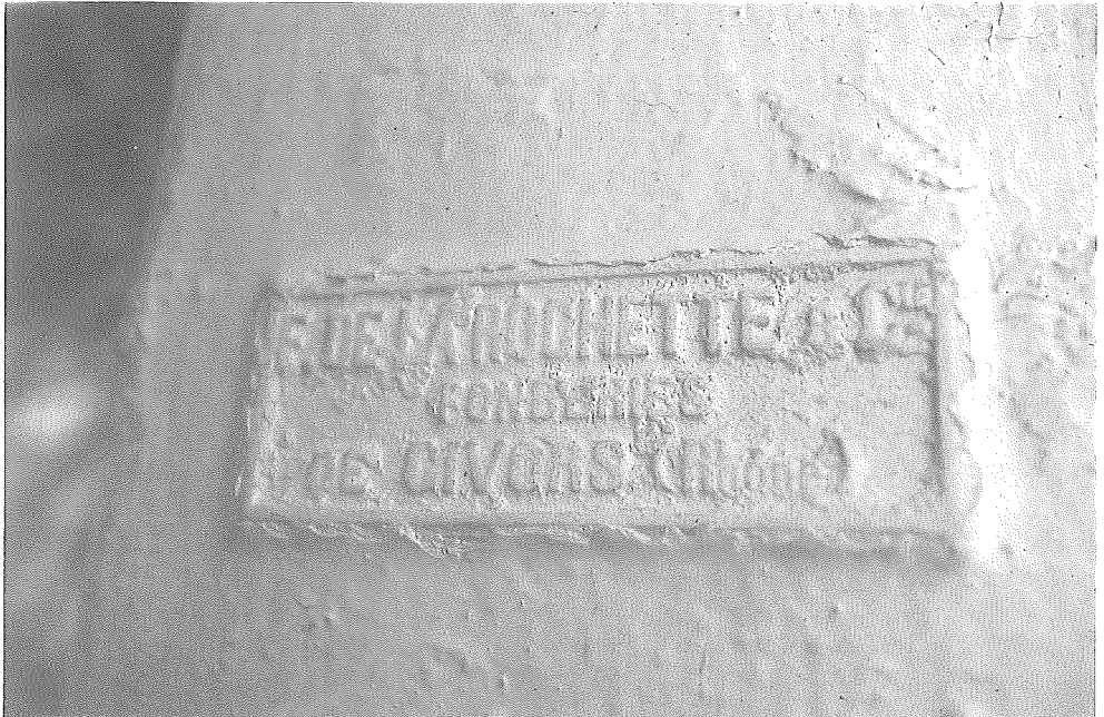
Sello en relieve con la marca del fundidor de la estructura metálica. (Foto: R. Marín)
