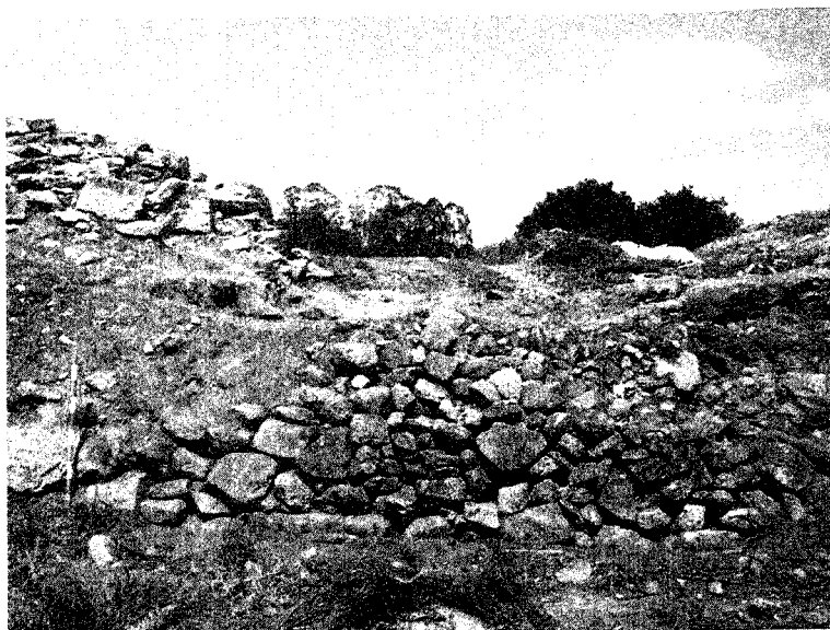
FIGURA 5: Sector 22/32 antes de excavar.
