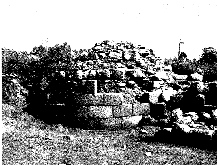
FIGURA 6: Vista del torreón S/W en el sector 22/23.
