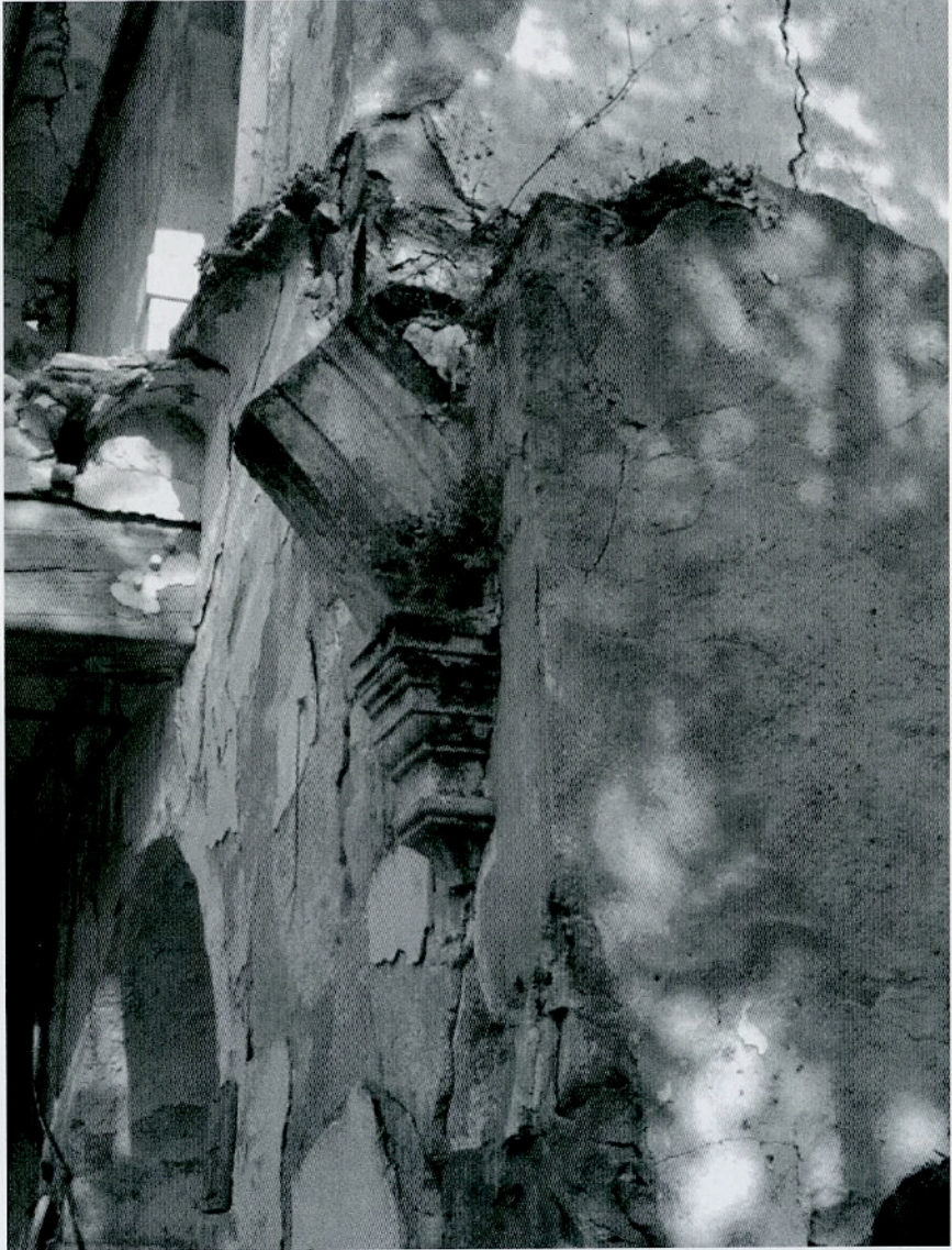
Arranque de un arco en el coro.
