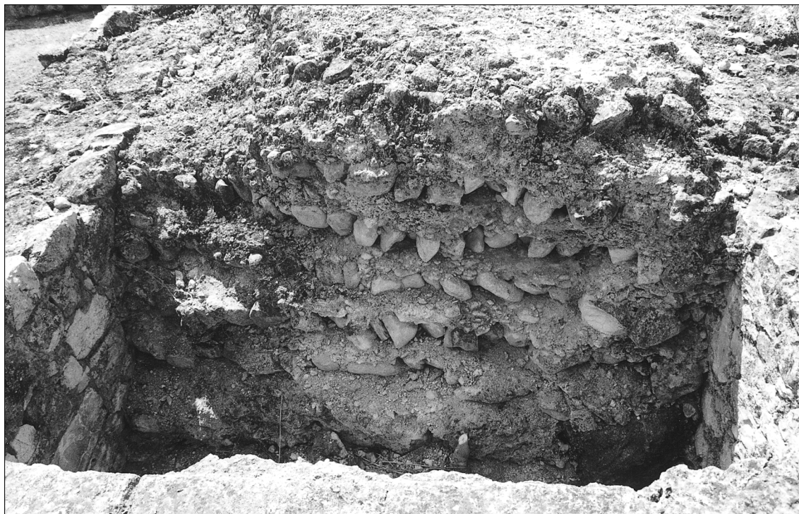
Aspecto del sistema constructivo que se emplea para corregir el desnivel de algunas dependencias de este edificio y como apoyo a su sistema de cimentación
