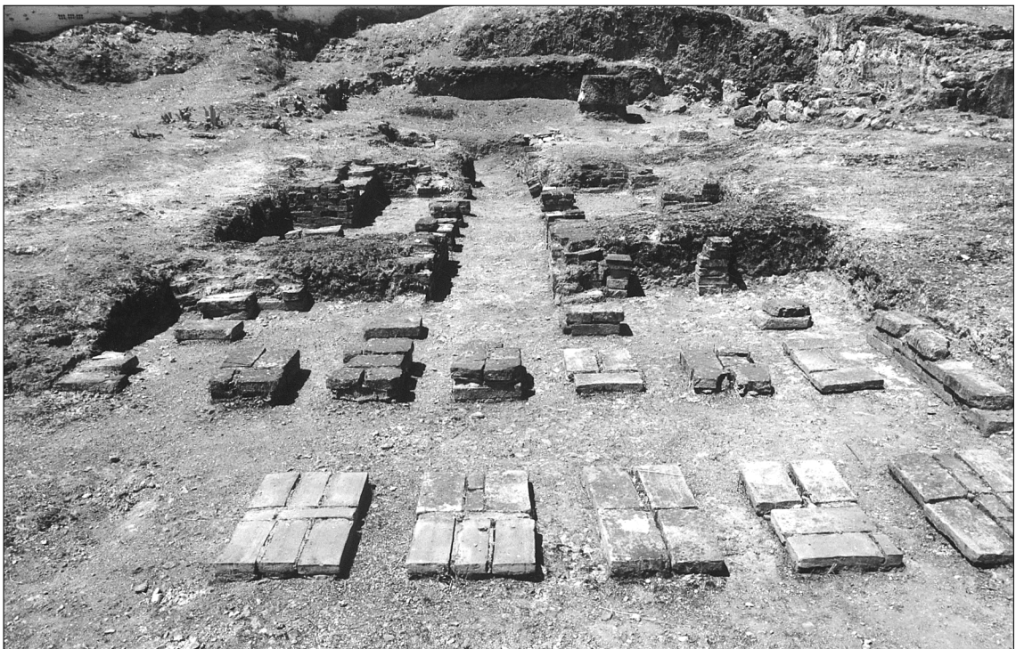
Vista desde el norte de la habitación calefactada más pequeña y partida en dos
