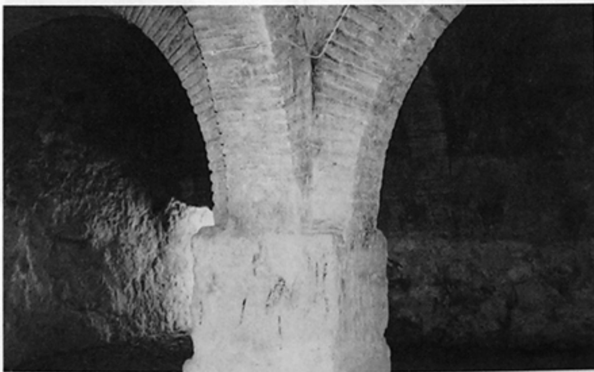
Foto núm. 2. —Planta baja de la Torre del Homenaje. En primer término el pilar central del que parten los 4 arcos que sostienen las bóvedas. A la izquierda, se aprecia la situación de puerta, y a la derecha los mechinales o manchas oscuras donde debió instalarse una tarima o repisa de madera. (Sánchez Tostado, 1995).
