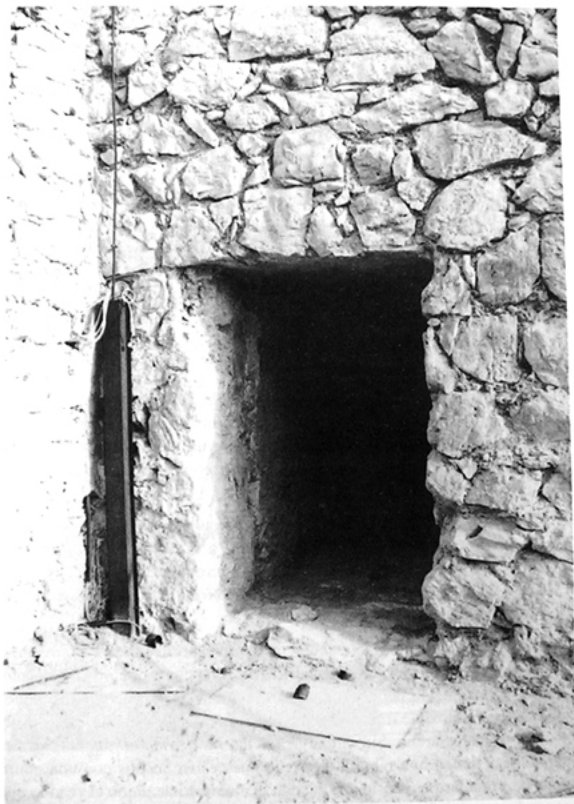
Foto núm. 4. —Puerta de acceso a la planta baja de la Torre del Homenaje. Pueden verse las marcas de la antigua puerta. La oscuridad impide ver el tremendo grosor de sus muros que alcanzan los 3,57 metros (Sánchez Tostado, 1995).
