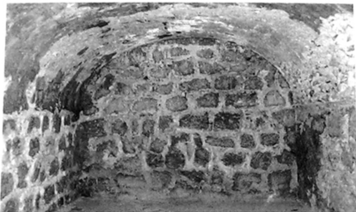
Foto núm. 11. —Aspecto del primer calabozo. En la pared del fondo se marca la situación de los mechinales localizados donde pudo haberse colocado las argollas. A la derecha, en la base de la bóveda, puede apreciarse el picado sobre el enlucido que dejaron descarnados los ripios de su fábrica. (Sánchez Tostado, 1995).
