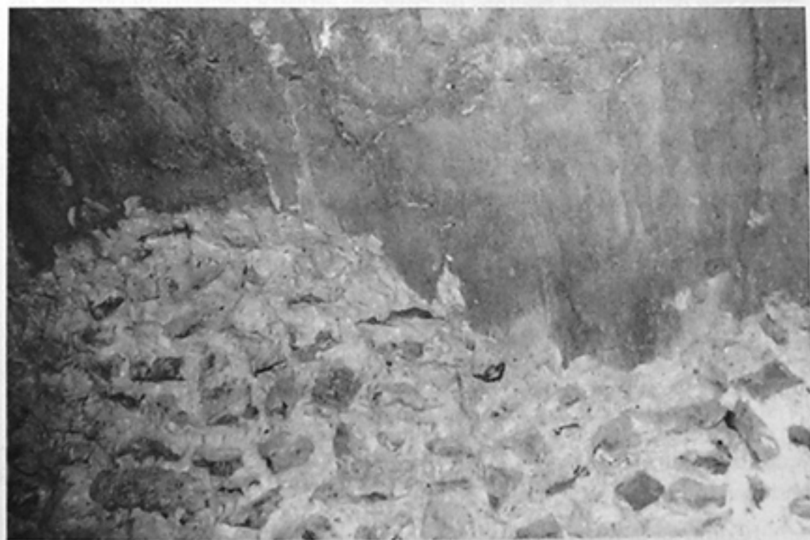
Foto núm. 14. —Destrozos por picado en la bóveda del primer calabozo. (Sánchez Tostado, 1995).
