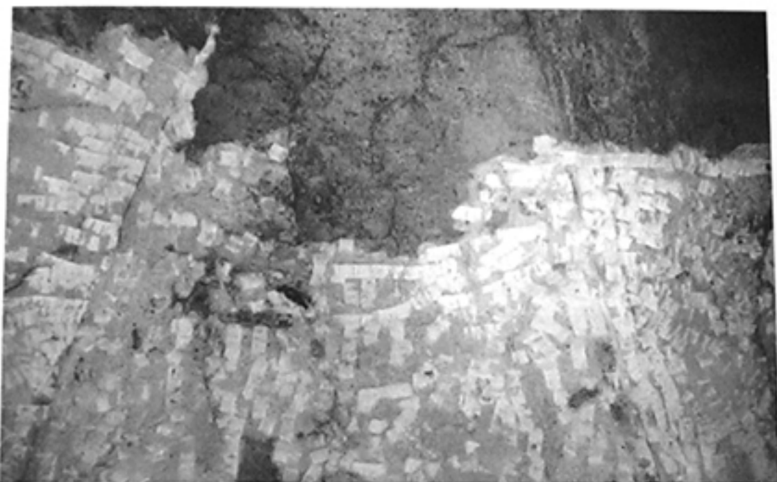
Foto núm. 13. —Muestra del destrozo producido por el desafortunado picado del enlucido original de yeso en las bóvedas de las dependencias subterráneas. (Sánchez Tostado, 1995).
