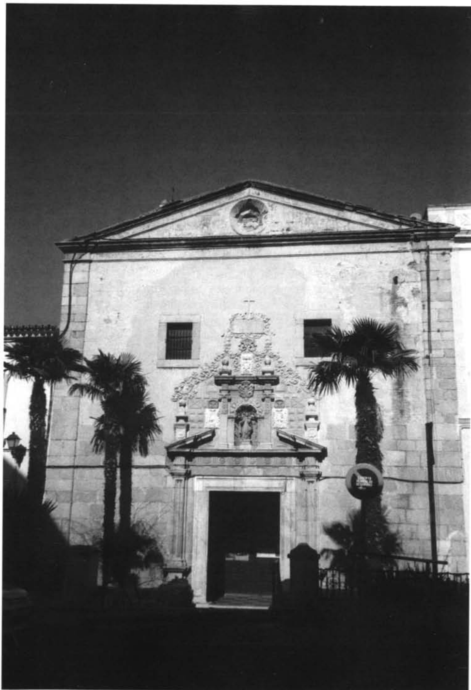
FIG. 9. Fachada de la Iglesia del Convento de los Descalzos Franciscanos.
