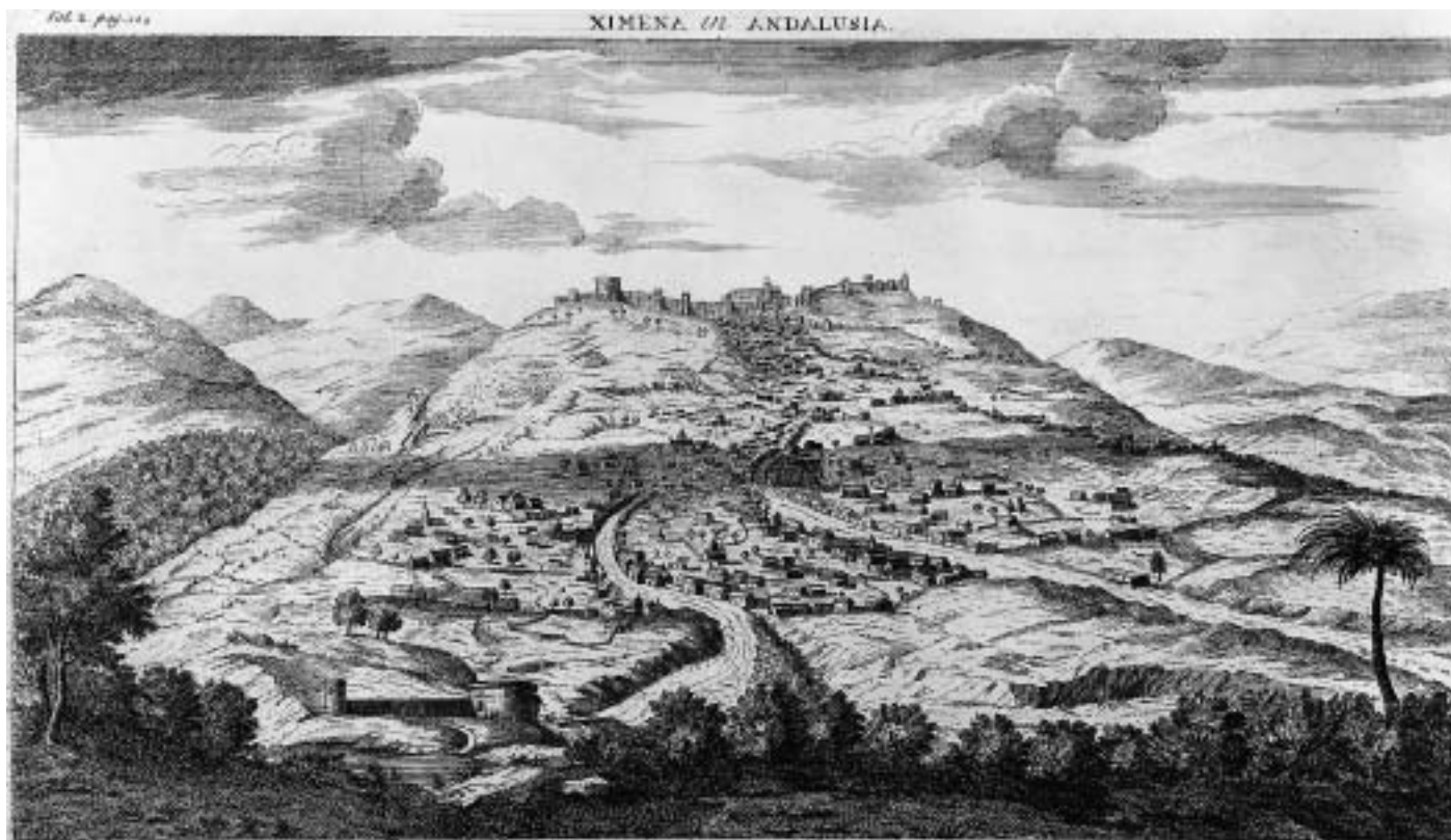
Fig. IX Jimena de la Frontera (Cádiz). Vista de la ciudad desde el S., con la muralla en la zona más alta del cerro, en la ladera el proceso de generación del casco moderno, y dos calzadas de acceso. Foto Biblioteca Nacional de España, ibid. , frente a p. 324.
