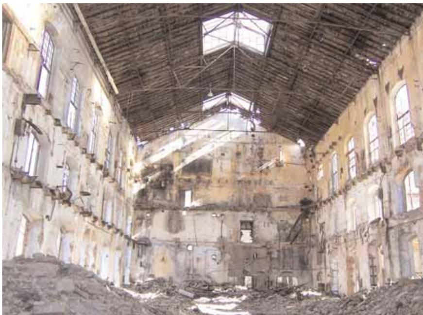
*Cuerpo de fabricación de la azucarera de Alagón desmantelado y vaciado*
