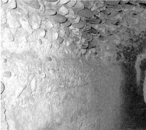
Fig. 8: Huellas del encofrado en la cloaca. 1.
