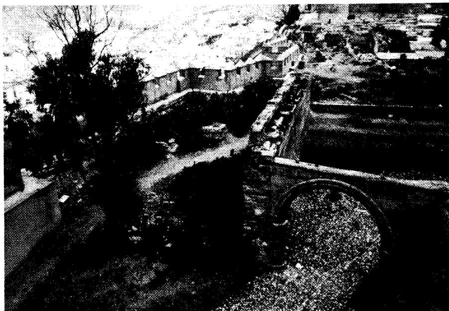
Lám. 5. Baluarte de S. Matías. En primer término el arco gótico.
