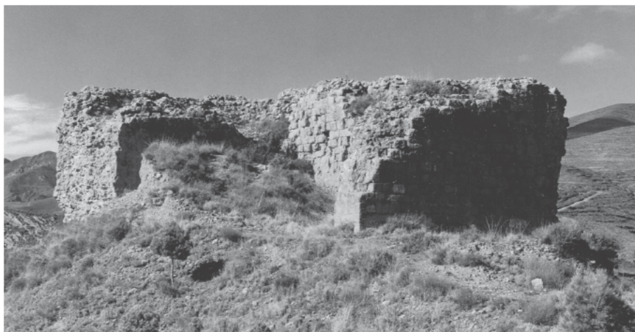
Lámina 2. Castillo sobre el Cerro de El Salvador desde el sudeste, antes de su restauración.
