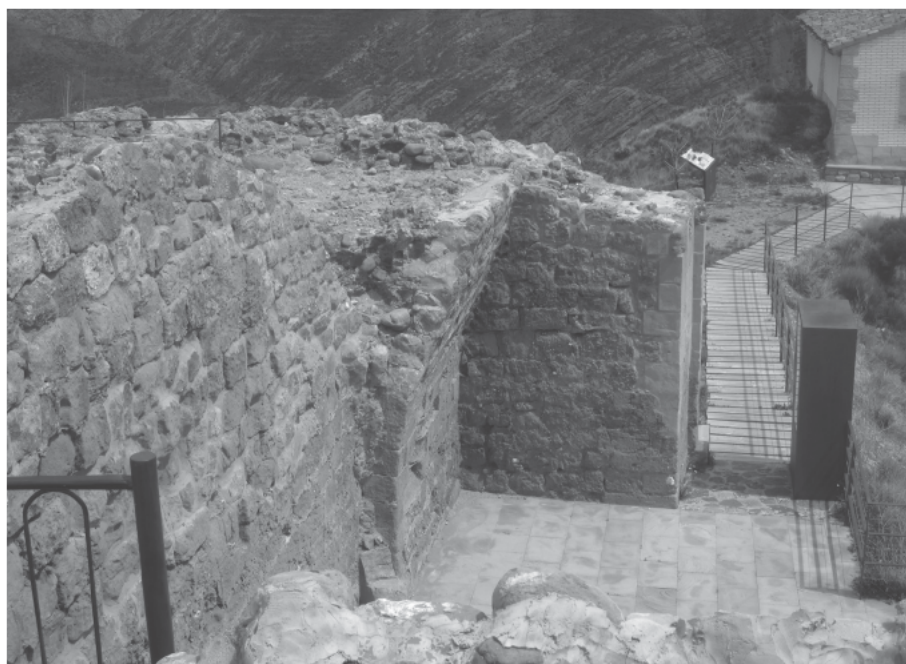
Láminas 14 y 15. Remate del muro norte hacia el oeste con el relleno de morrillo, y parte de la vertiente interior en sillería, antes y después de la restauración.
