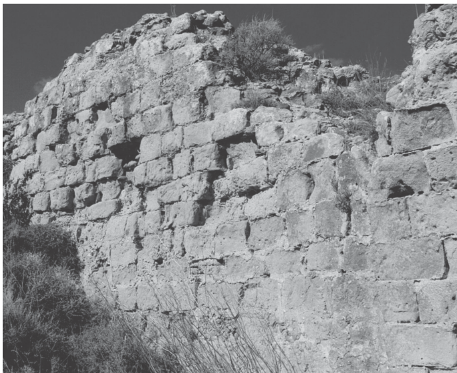
Lámina 13. Vertiente interna del muro norte en sillería.
