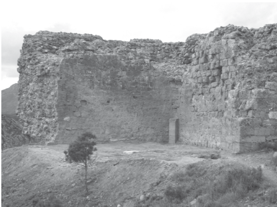
Láminas 17 y 18. Estado del castillo tras la excavación arqueológica.
