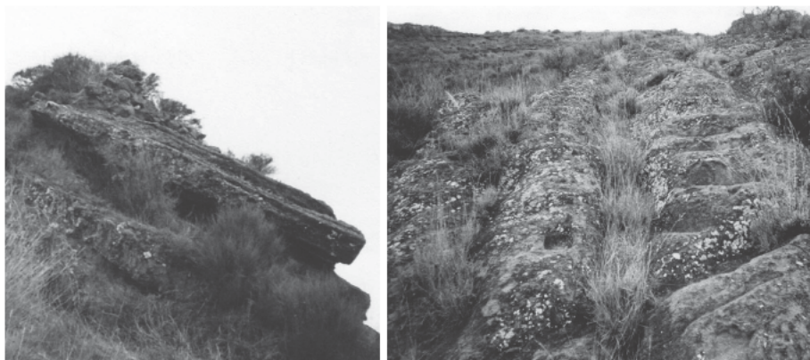
Láminas 7 y 8. Restos de construcción de tapial y sillarejo en El Castillar y canalizaciones realizadas en la roca en la zona de acceso a dicho lugar.
