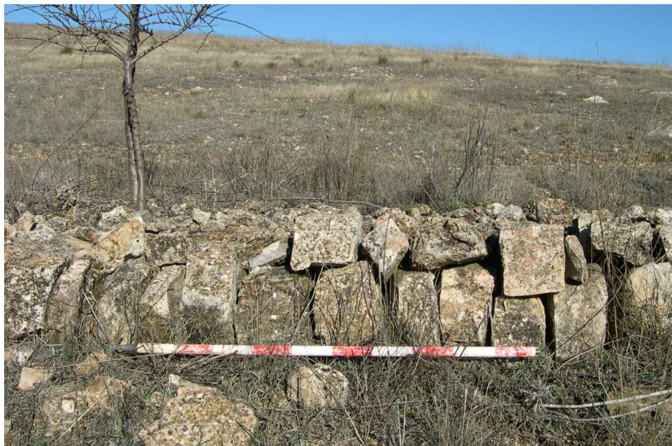
Fig. 10: Detalle de la técnica constructiva de la cimentación de toda la estructura: lajas dispuestas de forma vertical. Lado sur del recinto.
