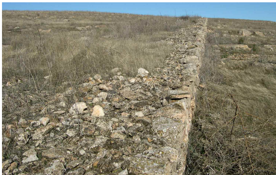
Fig. 8: Detalle del muro perimetral en el lado este.
