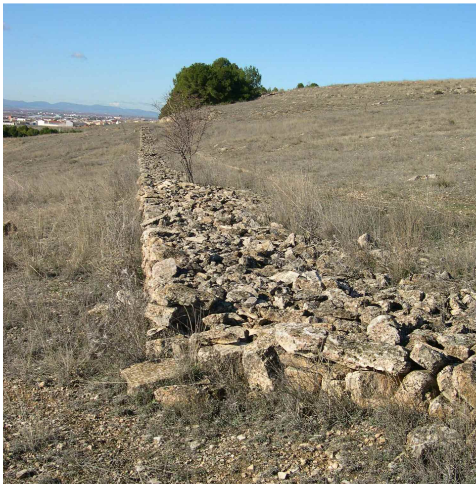
Fig. 5: Muro del lado sur.
