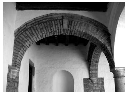
Abajo: Arco de sustentación construido con tablones coloniales. Claustro de Santo Domingo.
