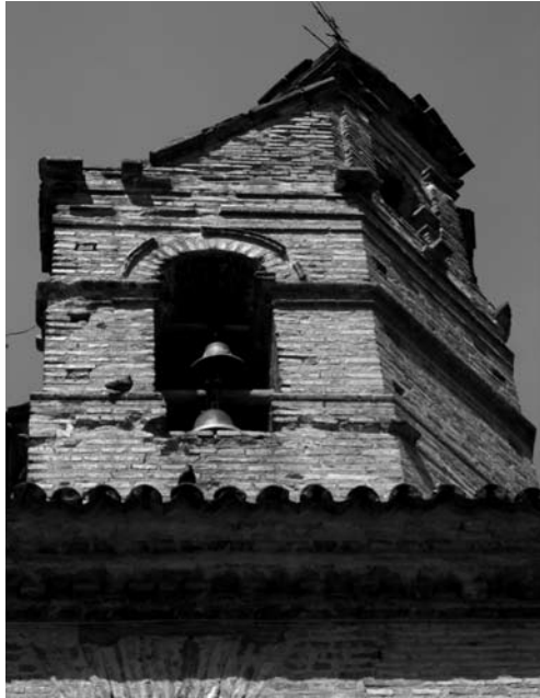
Izquierda: Mampostería en ladrillo a la vista. Espadaña templo de Santa Clara Derecha: Mampostería en ladrillo, torre de la iglesia de San Ignacio (sin revoque por las obras de restauración adelantadas actualmente).
