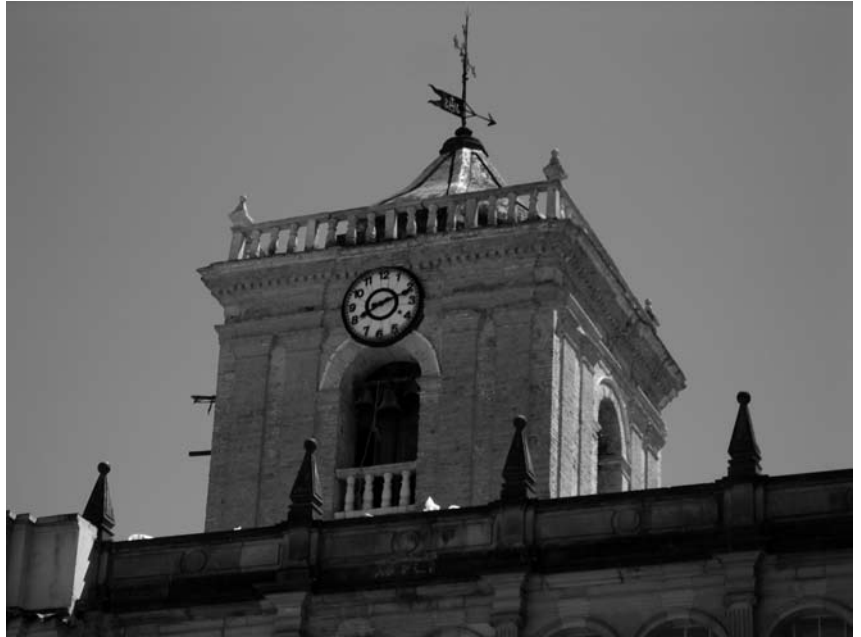
Izquierda: Mampostería en ladrillo a la vista. Espadaña templo de Santa Clara Derecha: Mampostería en ladrillo, torre de la iglesia de San Ignacio (sin revoque por las obras de restauración adelantadas actualmente).
