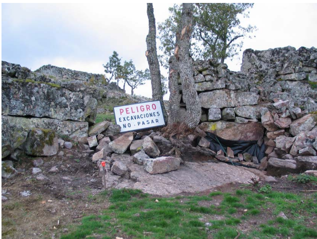
Fig. 200: Vista del acceso tras la caída de su parte oriental.
