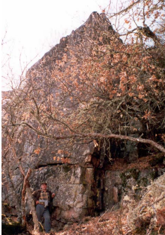
Fig. 88: Vista parcial del lateral Este antes de su limpieza (año 2002).
