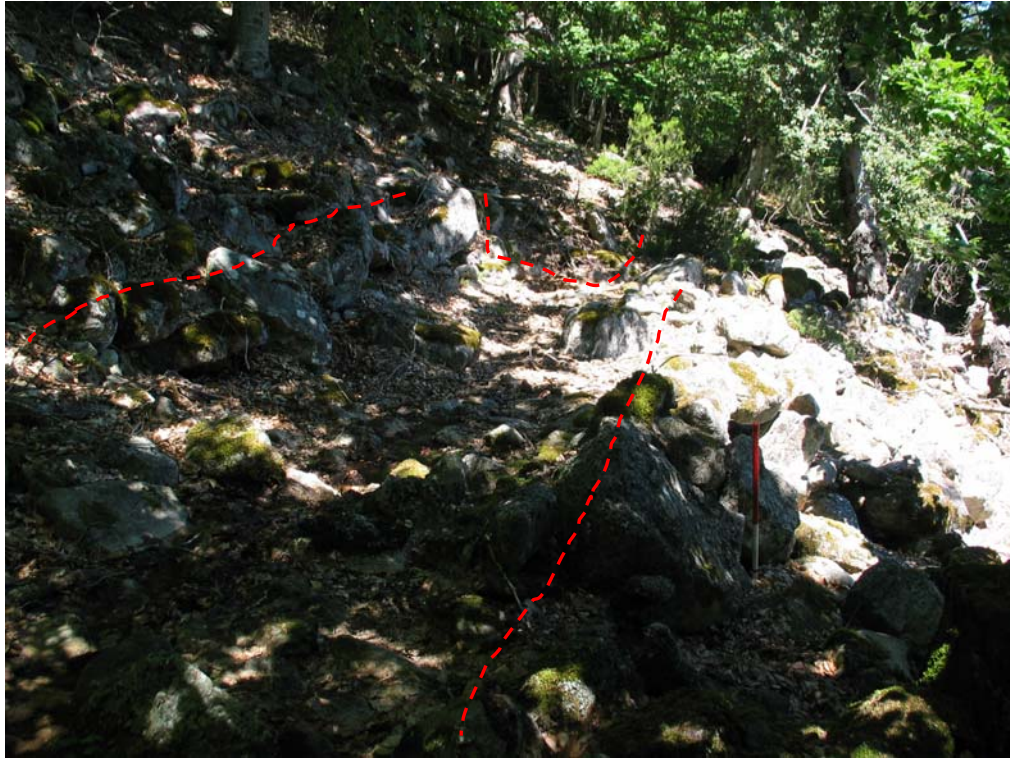
Fig. 79: Detalles de un paso estrecho del camino al atravesar un canchal. Tránsito difícil, incluso por el firme.
