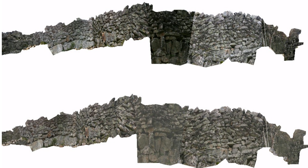
Figs 367 y 368: Parte superior, conjunto de texturas formando un tramo de muralla antes del tratamiento radiométrico. En la parte inferior, el mismo tramo una vez ecualizado.
