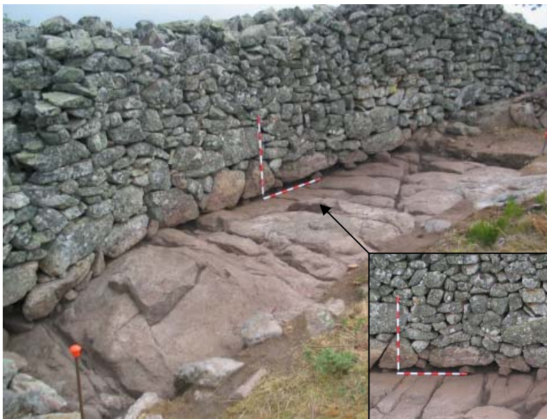
Fig. 127: Estado final del sector Detalle de los calzos de la cimentación
