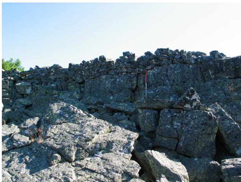
Fig. 41: Detalle de una parte del lienzo del muro I.
