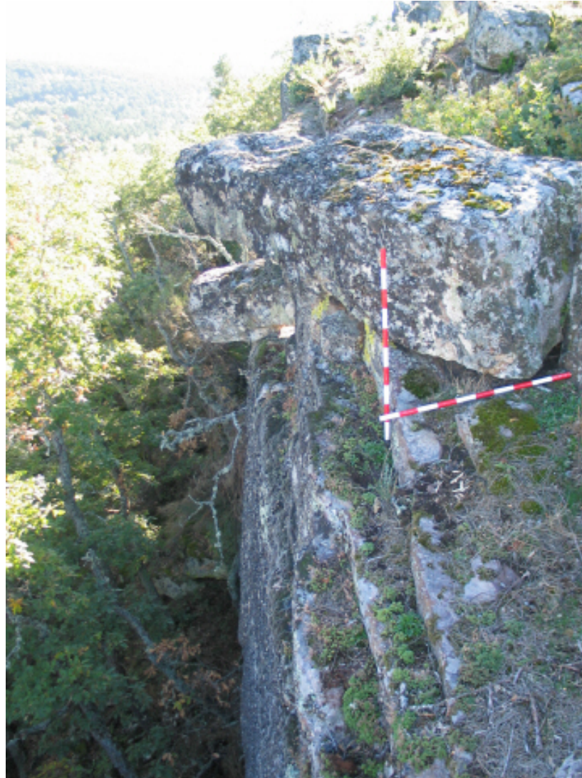
Fig. 89: Cortado Este de 15 m. de pared vertical con elementos voladizos en su parte alta
