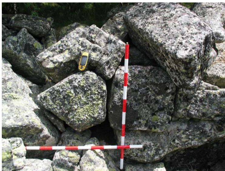
Fig. 61: Aparejo utilizado en la zona del acceso al recinto
