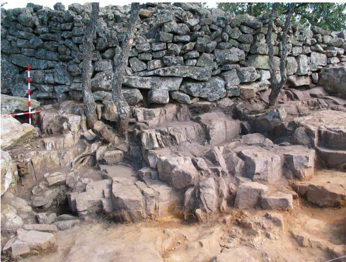
Fig. 172: Cimentación de la muralla 2 directamente sobre la roca madre.
