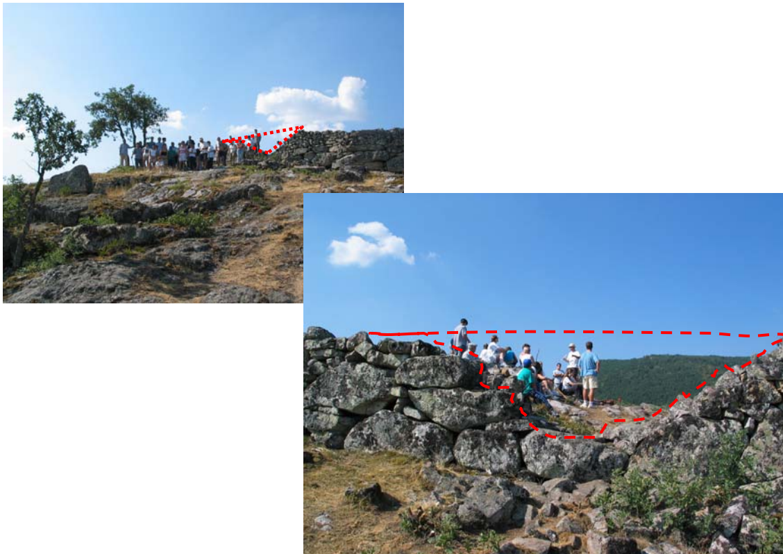
Figs. 144 y 145: Panorámica y detalle de la rotura de la muralla. U.E. 100.010
