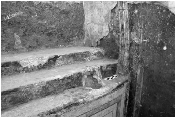
Figura 8. Detalle de las repisas del larario. Se aprecia la perforación en la que se colocaría un pedestal y el arranque de una de las imitaciones estucadas de pilastras que lo decoraban.
