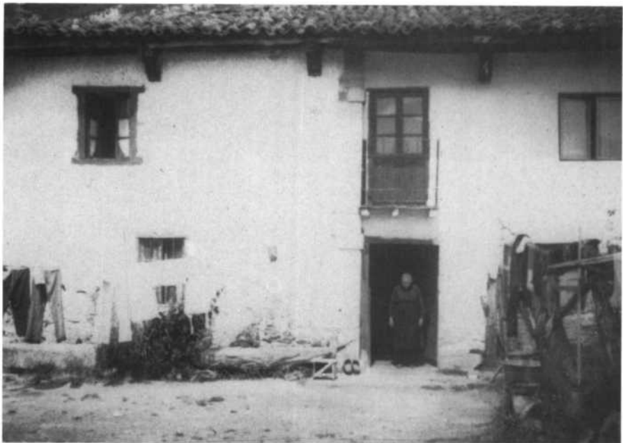
Figura 3.—Fachada principal: el balcón y la puerta nos indican las dos plantas de que constan las casas en Fuentes Carrionas.
