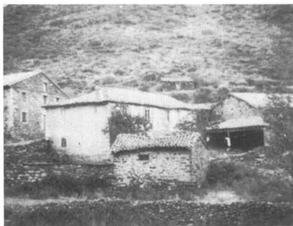
Figura 5.—Las casas aprovechan la ladera de la montaña. La fachada trasera queda disminuída en altura debido al cambio de nivel. En primer plano una hornera.
