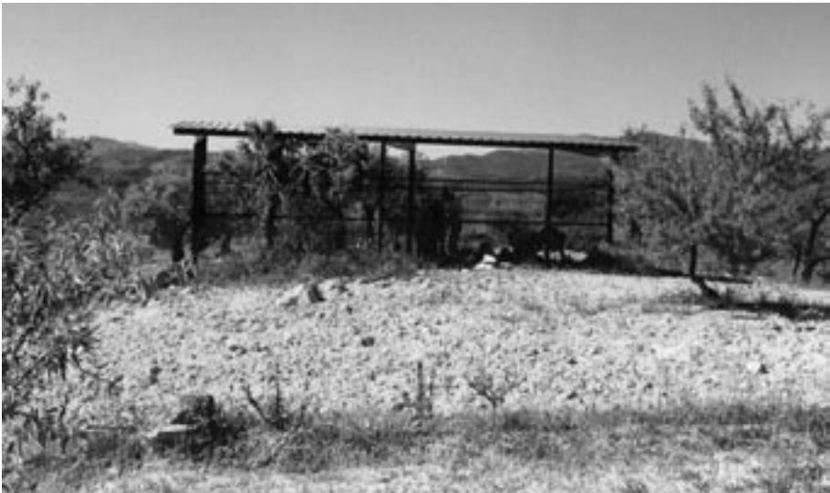
9. Vista general del conjunto finalizados los trabajos.
