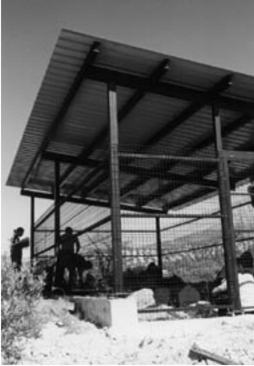
8. Detalle de la estructura de protección.
