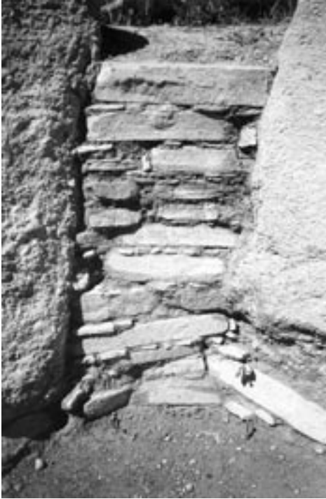
5. Detalle de la mampostería de la Cámara.
