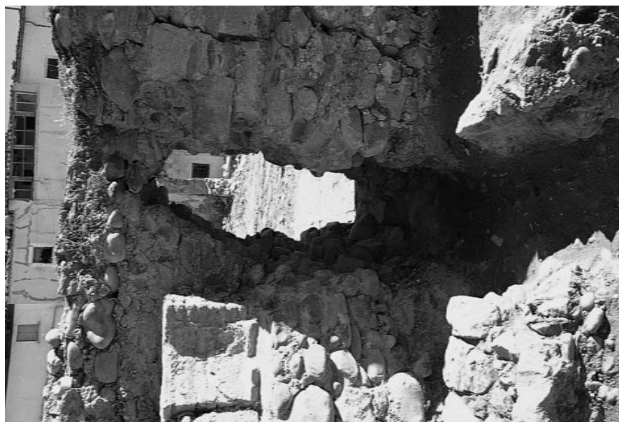
Fig. 3: Perforación en la pared efectuada por Gutiérrez Achútegui para comprobar si la Casa Santa se edificó sobre suelo firme o no.
