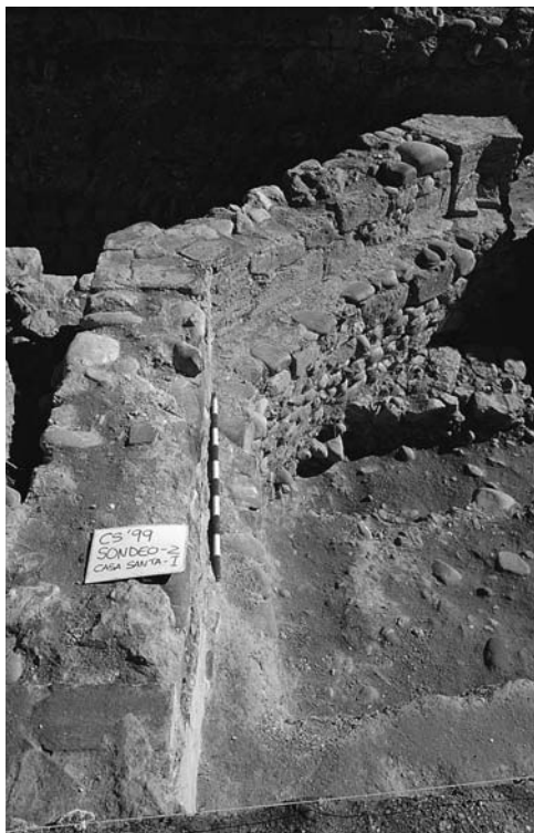
Fig. 5: Sondeo 2. Dos de los paños de esa estructura octogonal en la que se puede apreciar la fábrica de los muros y su cimentación.
