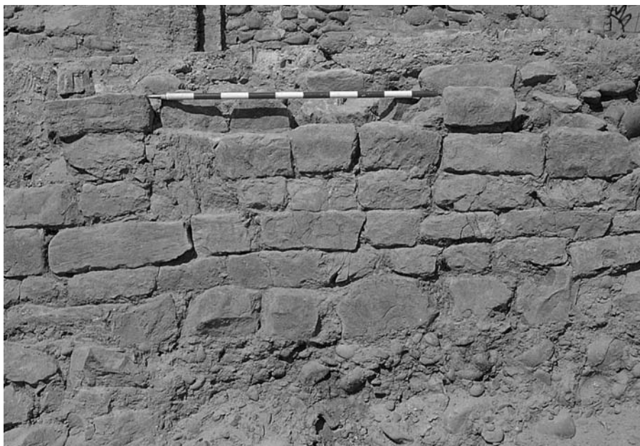
Fig. 22: Sondeo 5. Vista general del lienzo exterior del muro asentado sobre el suelo natural de la ladera.
