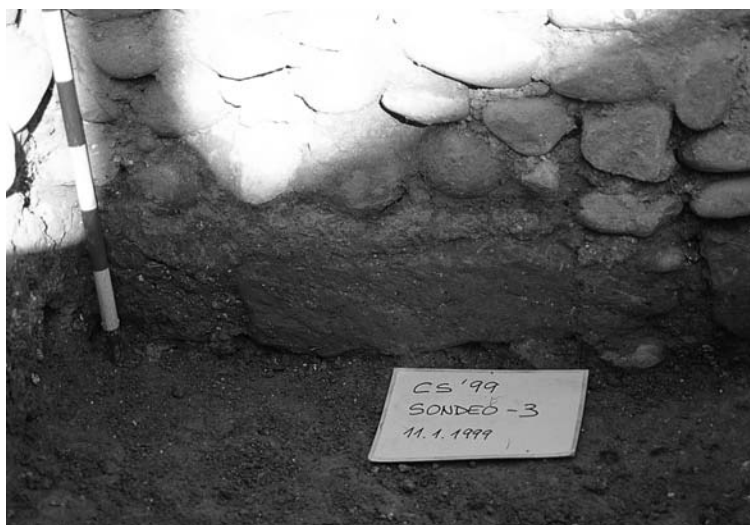
Fig. 21: Sondeo 3. Detalle de la cimentación de muro sobre sillares de factura romana.
