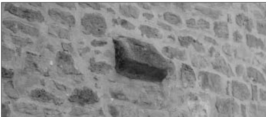
Foto 25. Portal de Aizaldea. Dovela de arranque del arco
