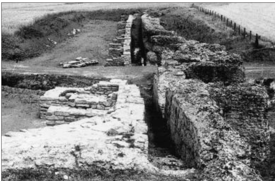
Vista general de la presa
