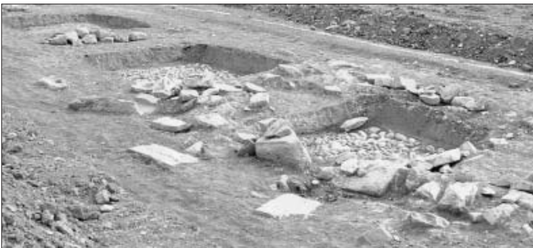
Encachados para el apoyo de los pilares del acueducto
