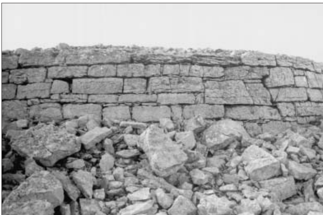
Paramento de la torre
