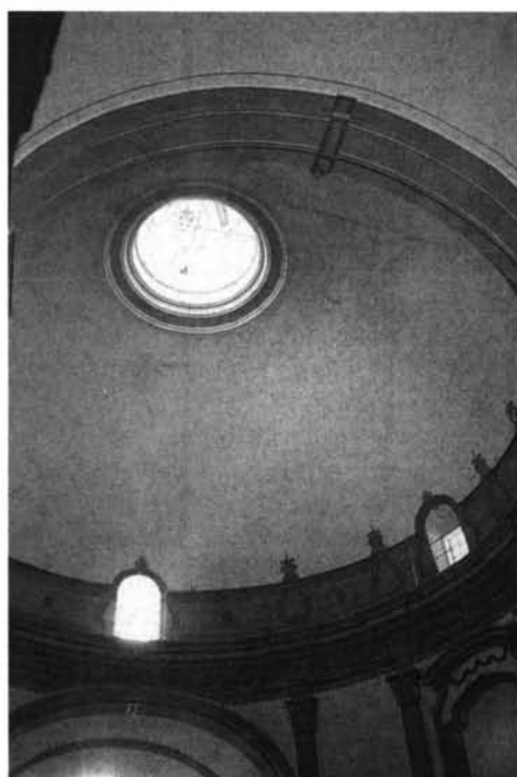
FIG. 8. Interior. Vista desde el santuario.
