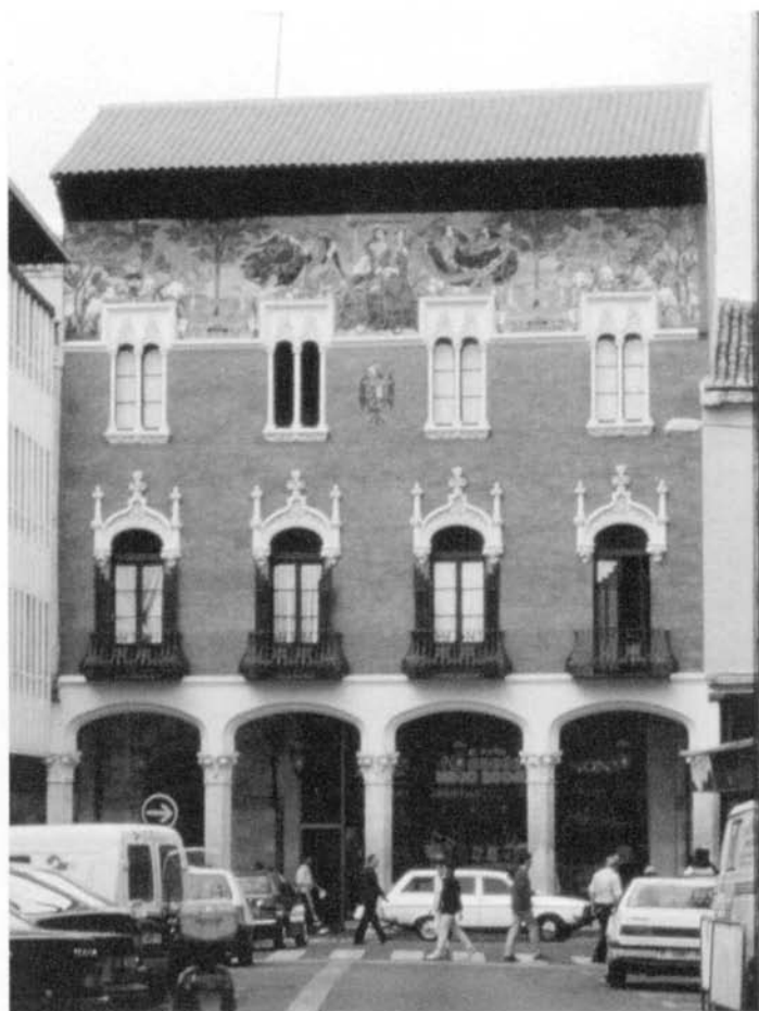
La fachada del Colegio de Villandrando
