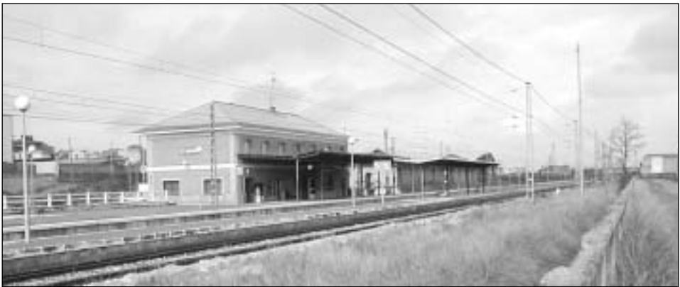
Figura 10.- Estación actual de Calahorra. Arriba a la izquierda almacenes y andenes primitivos.
