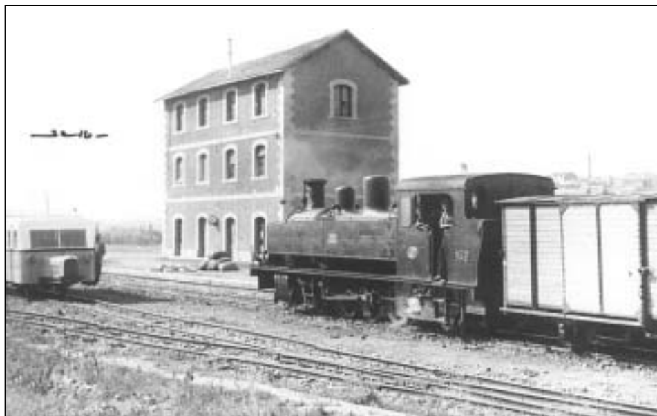
Figura 12.- Estación del trenillo .
