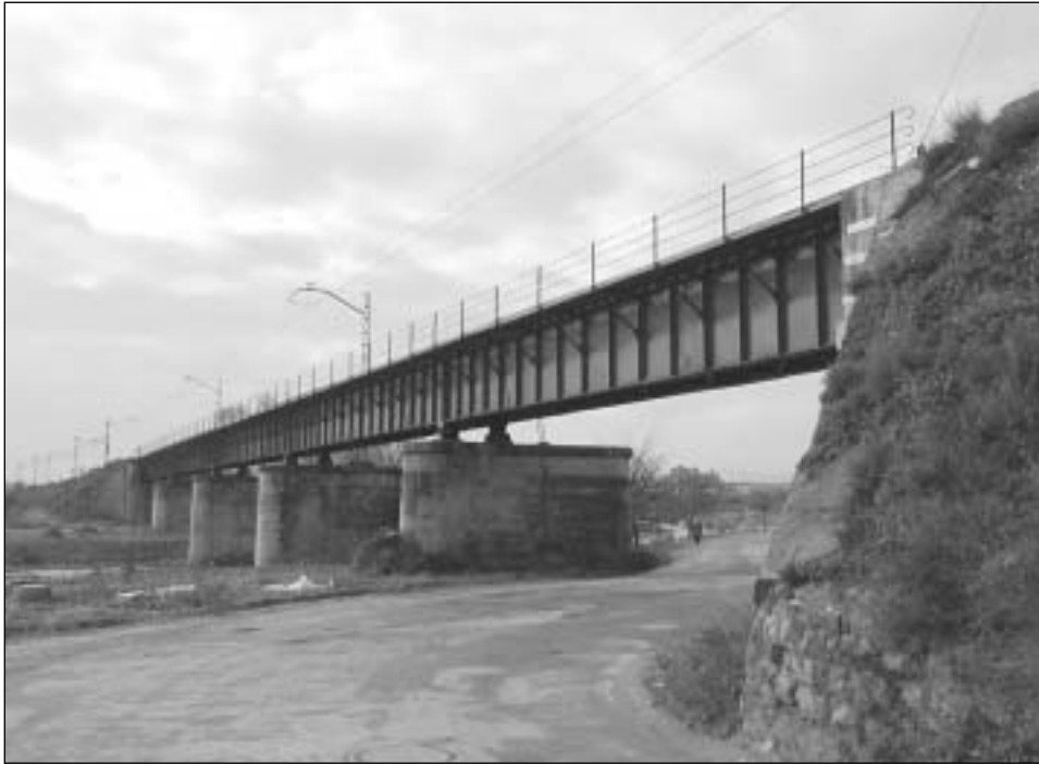
Figura 4.- Puente del ferrocarril sobre el río Cidacos conocido como “ punte de hierro ”.
