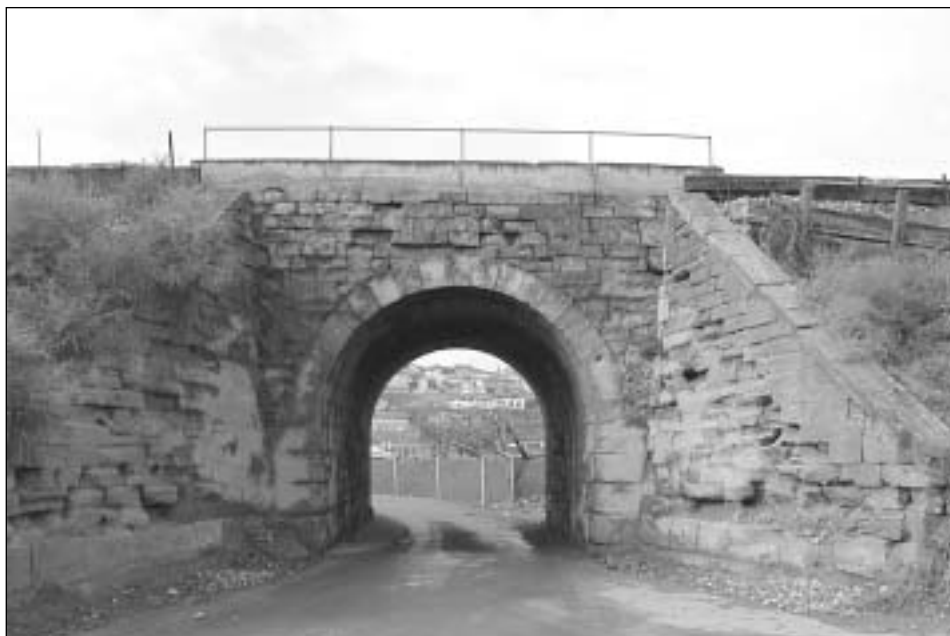
Figura 8.- “Arco de la vía” . Paso bajo el terraplén del ferrocarril en el término de Melero.
