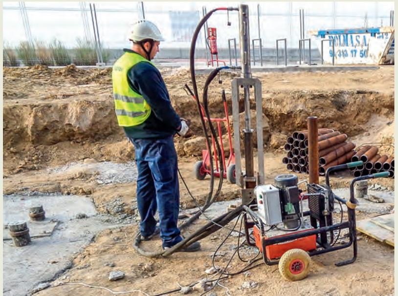
Arriba, equipo en fase de hinca. Abajo, encepado con tubo-camisa listo para ser hormigonado. En cuanto a los gráficos, a la derecha, disposición de micropilotes en encepados según proyecto. Abajo, definición de tubo-camisa.
