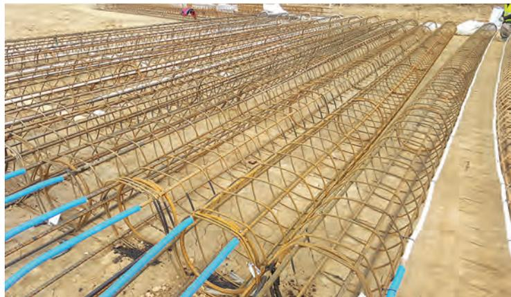
> “activados” con tuberías de agua, que son el captador de energía de la instalación de geotermia que da servicio a la máquina condensadora que proporciona la energía para el enfriamiento de la actividad productiva y la climatización del edificio.
