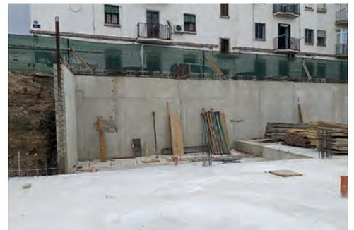
EN BASE A LOS DATOS DEFINIDOS EN EL ESTUDIO GEOTÉCNICO, SE DISEÑÓ UNA CIMENTACIÓN MEDIANTE LOSA DE HORMIGÓN ARMADO
