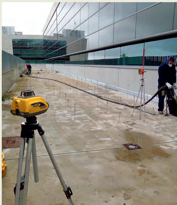
sistema de monitorización geoelectrico ERT 3D, observando la reducción de vacíos y de humedad, hasta que los resultados obtenidos muestren que el terreno asentado bajo la cimentación ha alcanzado valores geognósticos máximos que no podrán ser mejorados con otras inyecciones.
