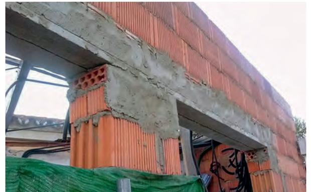
Figura 2: apoyos inadecuados bajo dinteles realizados con ladrillo.
