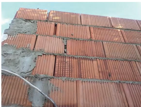
Figura 4: aberturas de encaje de las juntas verticales con espesores diferentes y con la inclusión en algún otro caso de mortero de cemento (incorrecto).
