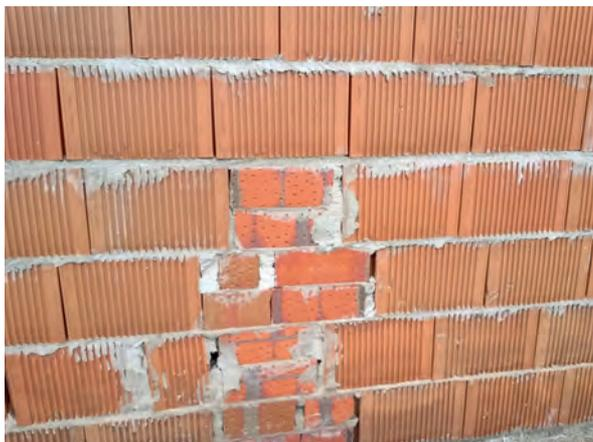
Figura 3: inclusión de varios ladrillos perforados entremezclándolos en una fábrica de bloques cerámicos aligerados (incorrecto).
