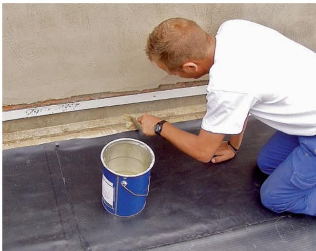
Figura 1: zona lateral de cubierta no transitable bituminosa (arriba).
