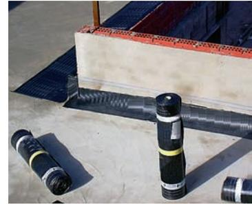
Fig. 4: colocación de la 'banda de adherencia' en un encuentro con pretil (erróneamente no se ha aplicado antes una imprimación bituminosa líquida).
