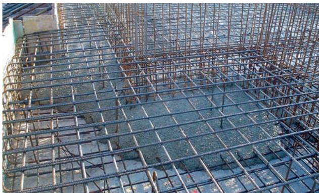
Figura 1: ejecución de losa de cimentación.
