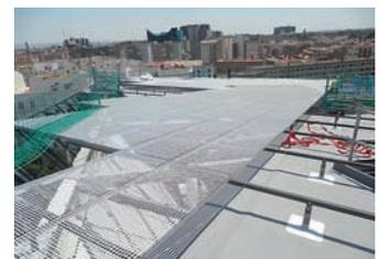
4 La fachada se cubre mediante bandejas de chapa de aluminio de 3 mm de espesor, creando una envolvente continua.
