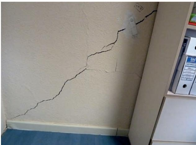
Cuando en las estructuras de hormigón armado aparecen las grietas, los daños en cerramientos y tabiques son importantes, puesto que las estructuras son mucho más flexibles y los materiales que las forman mucho más resistentes.
