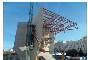
2 La gran estructura metálica de la que pende el edificio se soporta en grandes pilares encofrados de hierro macizo.
