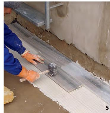
Fig. 5: proceso de colocación de baldosas de mármol mediante adhesivo.
