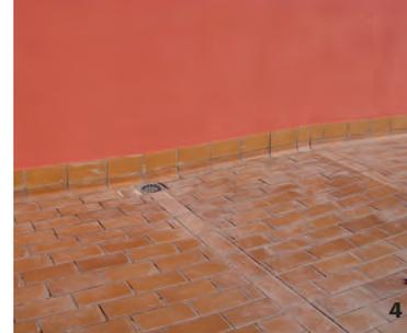
Fig. 4: solado de baldosas cerámicas ya dispuestas en una azotea.
