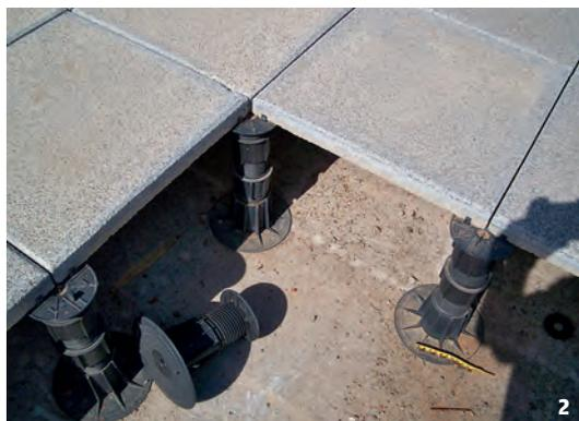
Fig. 1: vista del soporte estructural de una cubierta deck.
