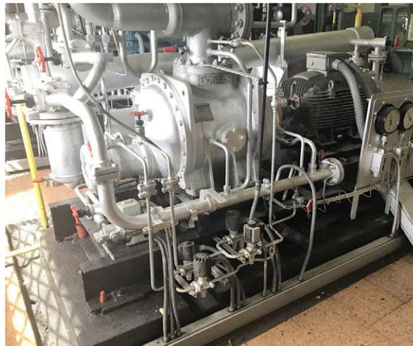
Figura 11. Motor de imanes permanentes de la marca WEG modelo Wmagnet accionando un compresor Howden.
