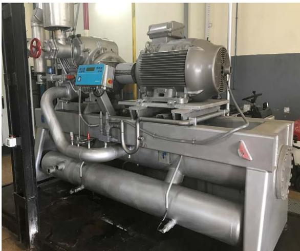
Figura 10. Motor de imanes permanentes de la marca WEG modelo Wmagnet accionando un compresor Sabroe.
