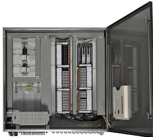
Asco Numatics 580 Charms nodo electrónico e islas instalados en un armario con Charms.
