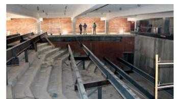
5 Cubierta del aula magna una vez desencofrada y comienzo del desmontaje de la estructura provisional de cimbra.
