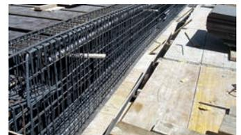
3 Armado de las vigas postensadas de cubierta del aula magna con vaina de postensado.
