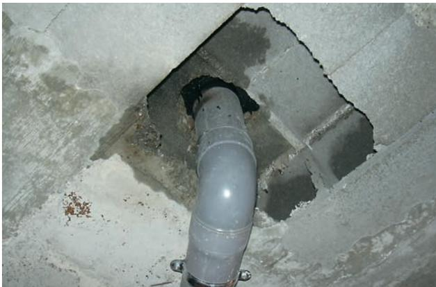
Fig. 1: cazoleta en cubierta plana transitable.
