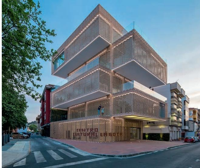
LA DISPOSICIÓN DE PILARES, LA LIMITACIÓN DE ALTURA DE CORONACIÓN Y LOS GRANDES VOLADIZOS NECESITARON LA EJECUCIÓN DE LOSAS DE FORJADO POSTESADAS CON CANTO LIMITADO
