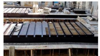
2 Encofrado de vigas postensadas en forjado de cubierta del aula magna.
