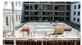
4 Cubierta del aula magna una vez hormigonada con estructura de galería terminada.
