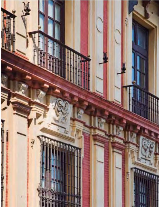
Figura 1. Fachada del Palacio Arzobispal de Sevilla. Restauración con morteros de cal y morteros de estuco. Terrajados y avitolados.
