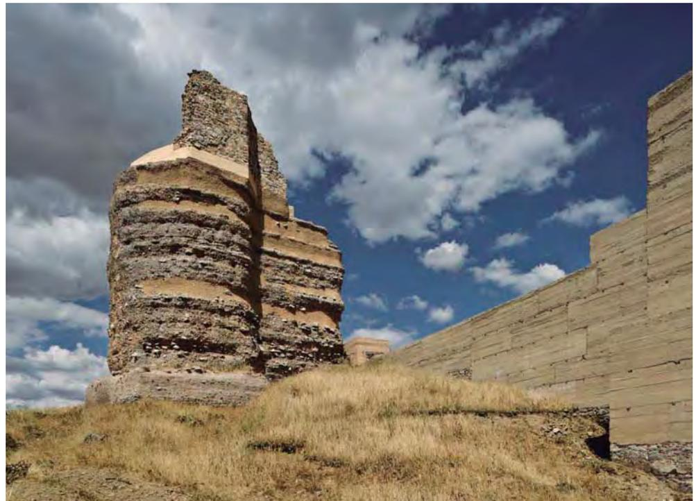
Figura 13. Restauración de la Alcazaba de Reina. Tapial con base de mortero de cal
