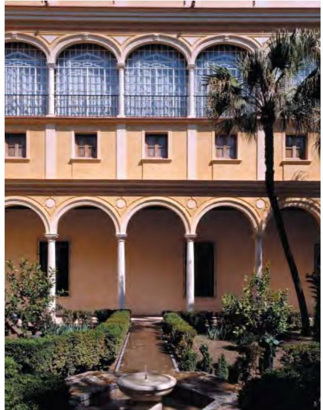
Figura 2. Fachada del Jardín del Príncipe del Real Alcázar de Sevilla. Restauración con morteros de cal, morteros de estuco y cales hidráulicas. Terrajados.
