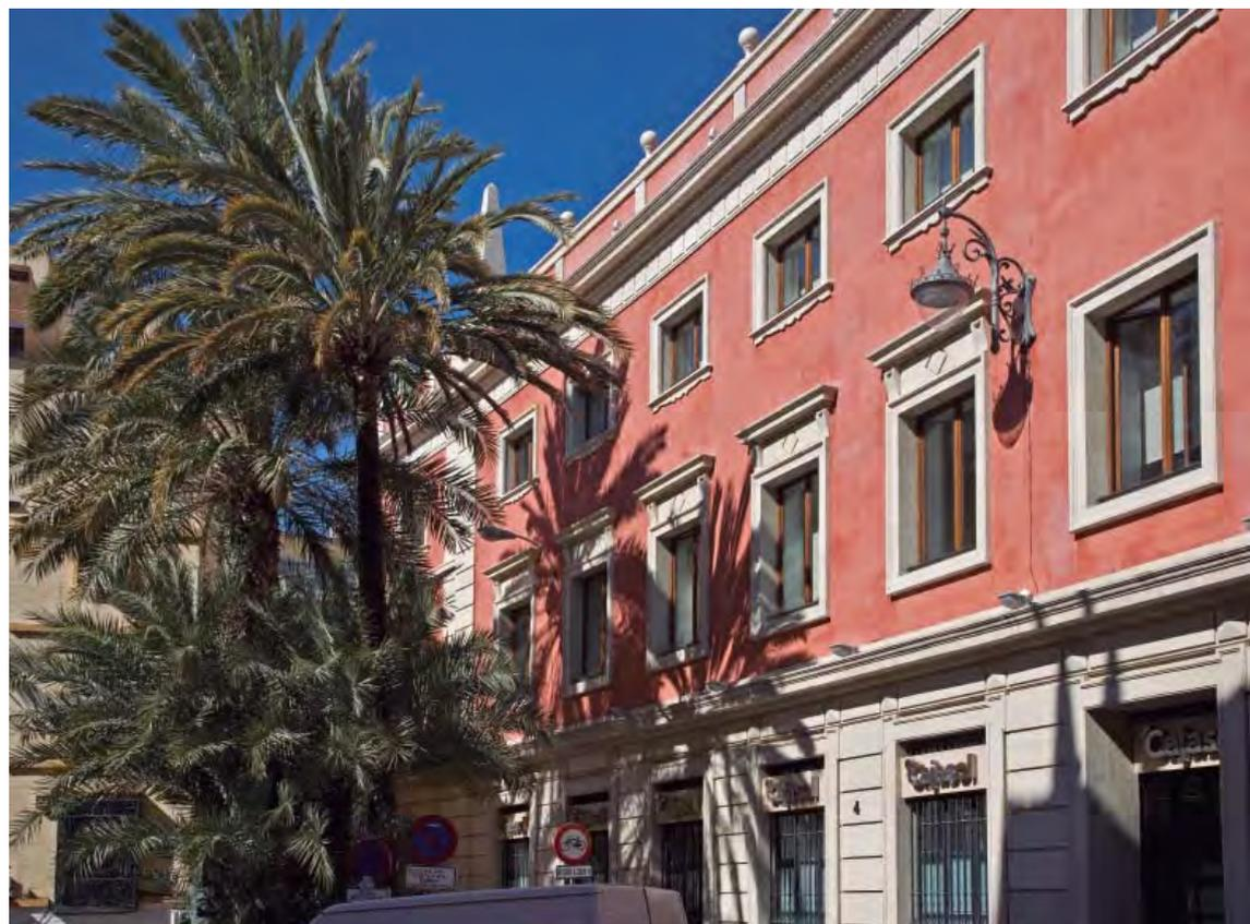
Figura 9. Entrecárceles. Mortero de cal coloreado en masa
