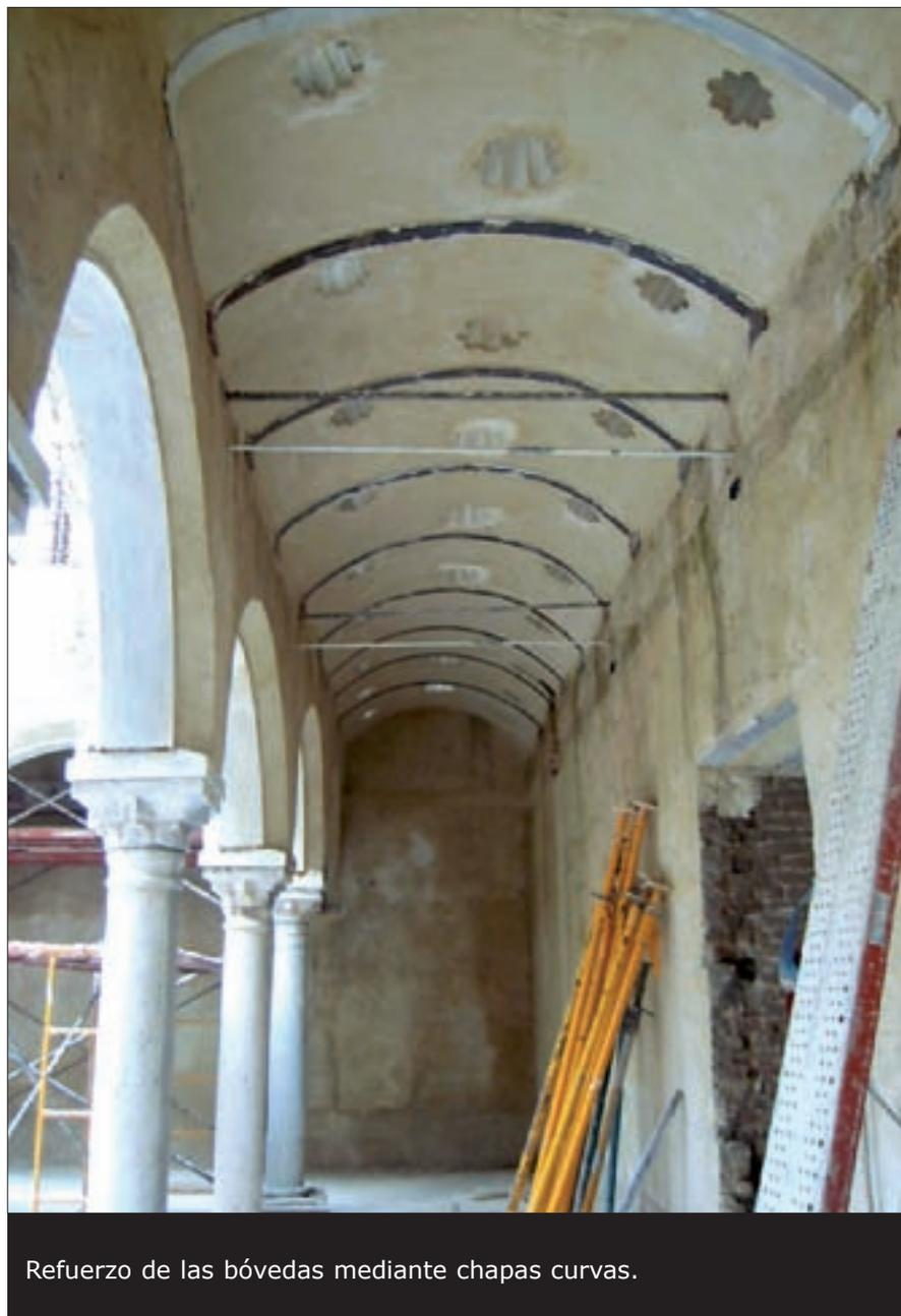
Refuerzo de las bóvedas mediante chapas curvas.
