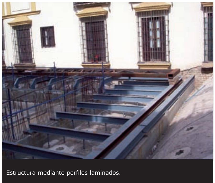
Estructura mediante perfiles laminados.
