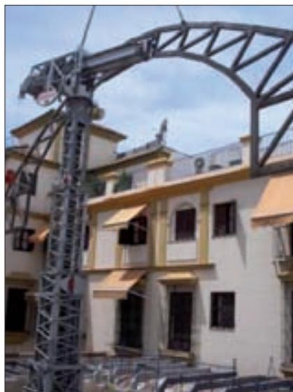
Montaje de las cerchas que componen la estructura de soporte de la cubierta.
