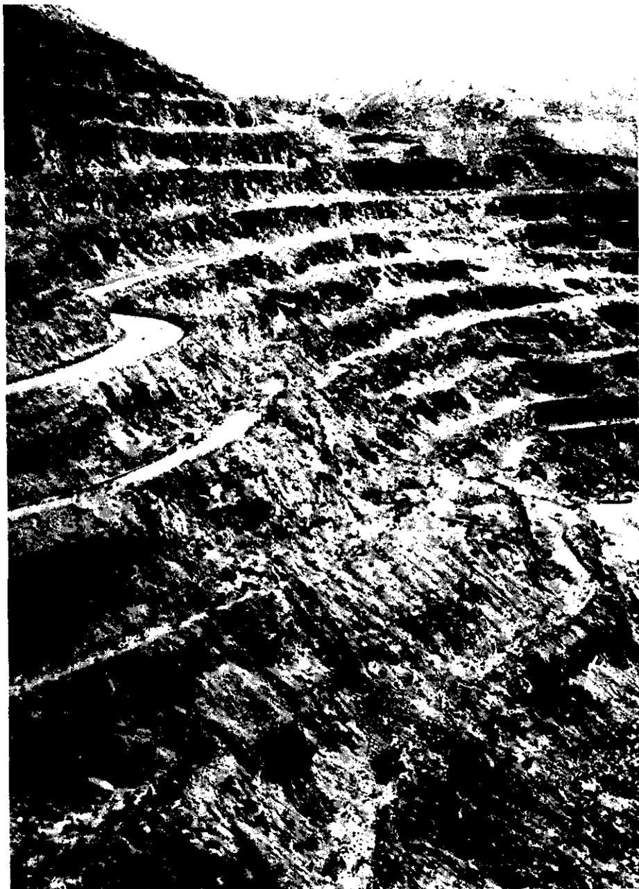
*Fig. 1. —Morfología en gradas que presentan las canteras a cielo abierto en la Sierra de Cartagena.*
