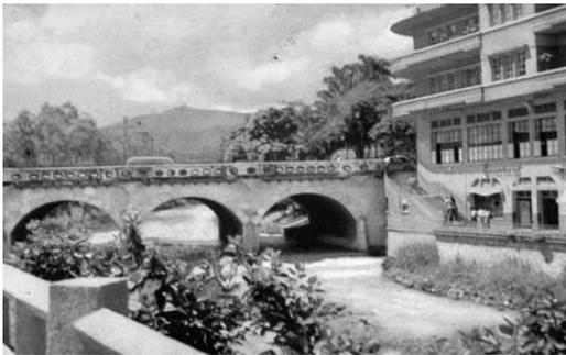
Figura 7. Vista del puente sobre el río Cali luego de la ampliación hecha en 1945 mediante la cual se adosaron sendas estructuras de hormigón a cada lado. Fuente: colección particular (1947).
