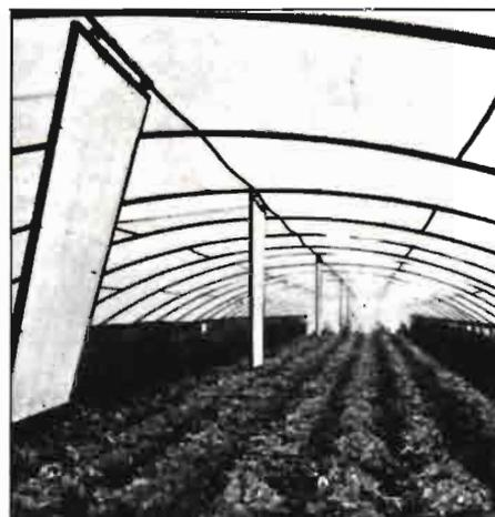
Invernadero de túnel construido con hierro galvanizado.
