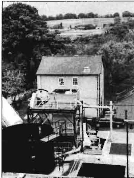
*Tanque utilizado por la compañía de suministros de agua potable para descontaminación de aguas. Es costoso y no es solución por el exceso de nitrógeno en los ríos en muchas zonas.*
