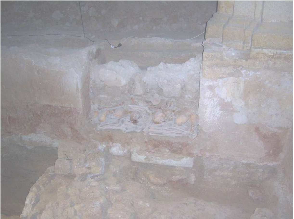
Imagen 7. Excavación realizada en la Iglesia de Nuestra Señora de la Asunción de Luque en 2012 (fotografía del autor).
