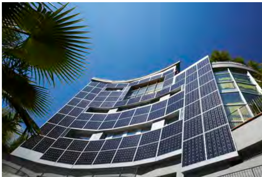
Figura 4-11 Ejemplo revestimiento fotovoltaico de fachada
