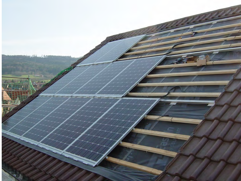
Figura 4-3 Módulos superpuestos tejado [81]
