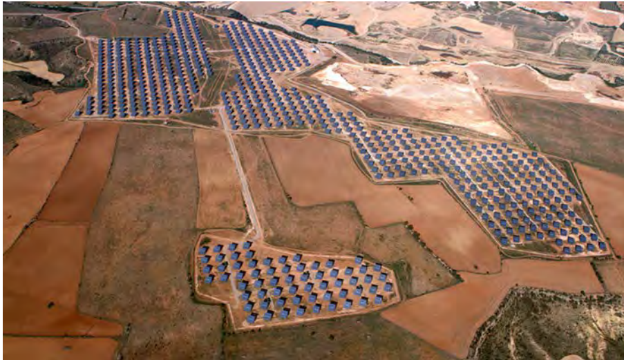
Figura 4-1 Parque Solar Lasesa 9MW
