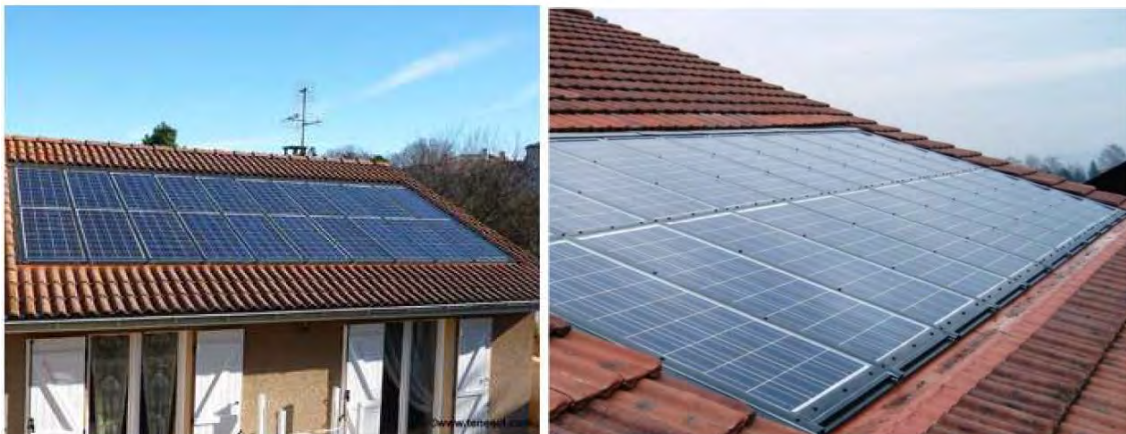
Figura 4-6 Tejas fotovoltaicas Sun Power-Tenesol [84]
