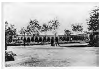
Pabellón de Maquinaria 47
