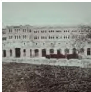
Imagen 47: Fotografía antigua de la Plaza de Toros, primera sede del Club Taurino 315 .
