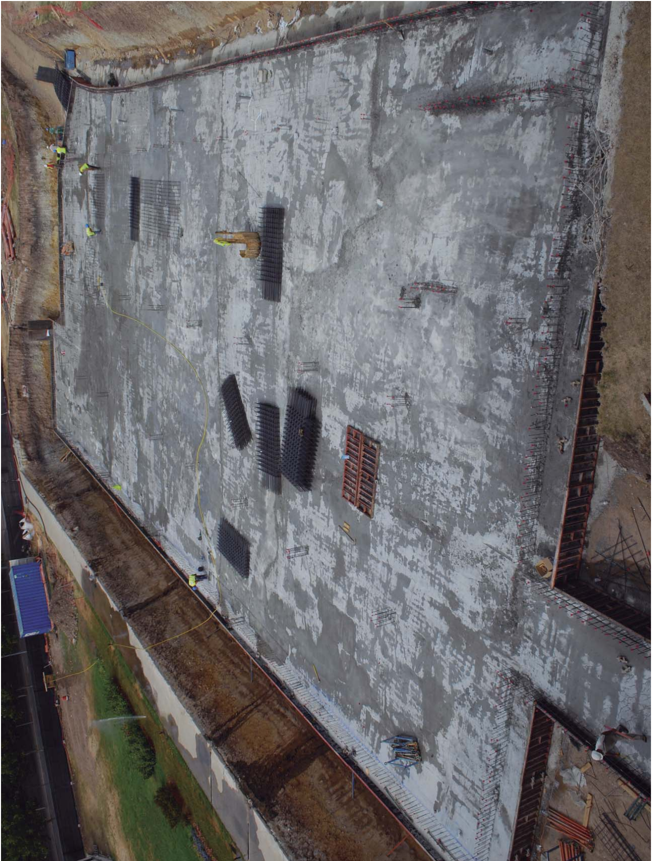
Fig. 5 – Hormigonado de la losa de cimentación
