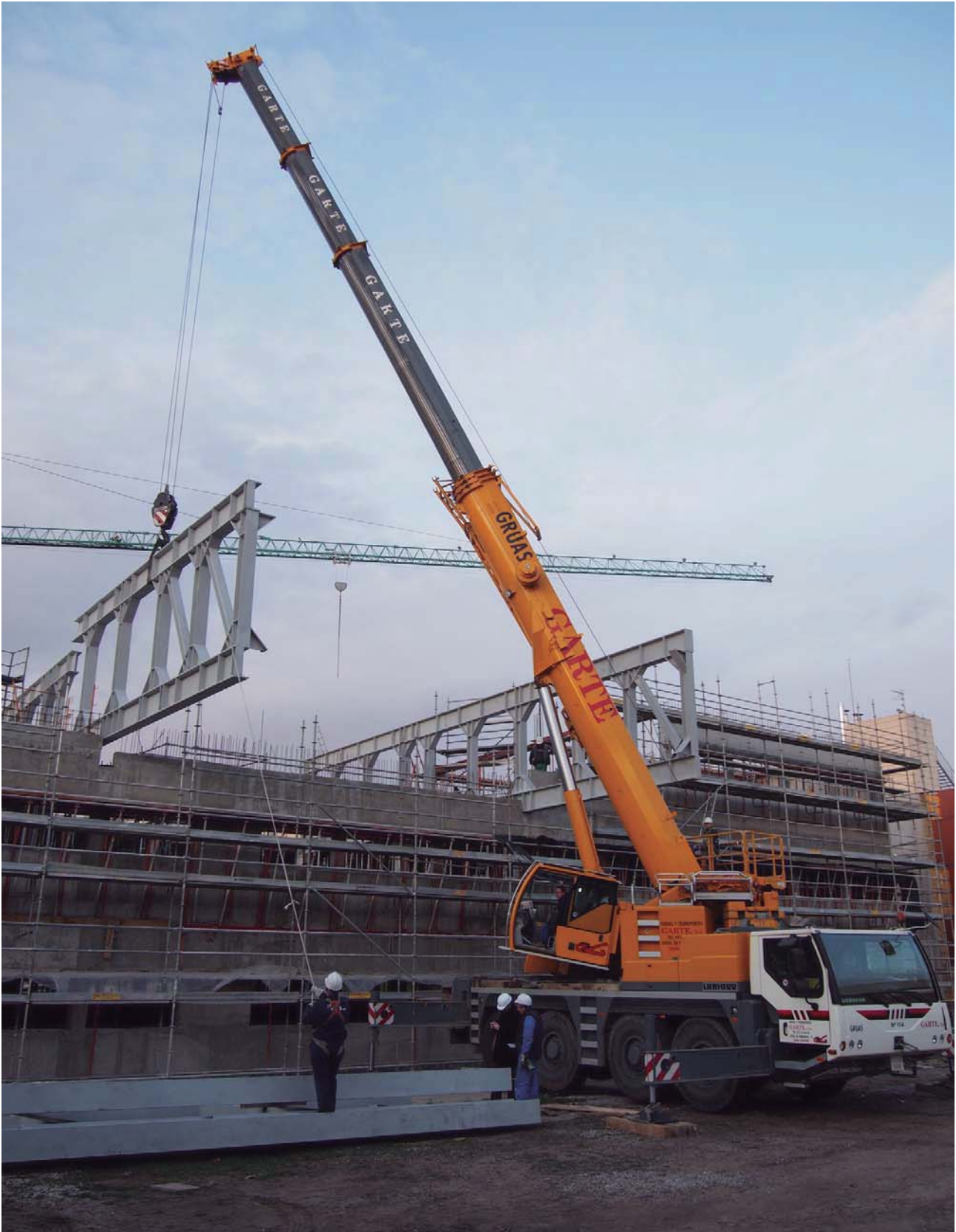
Fig. 28 – Colocación de los dos tramos exteriores de la estructura metálica del voladizo.
