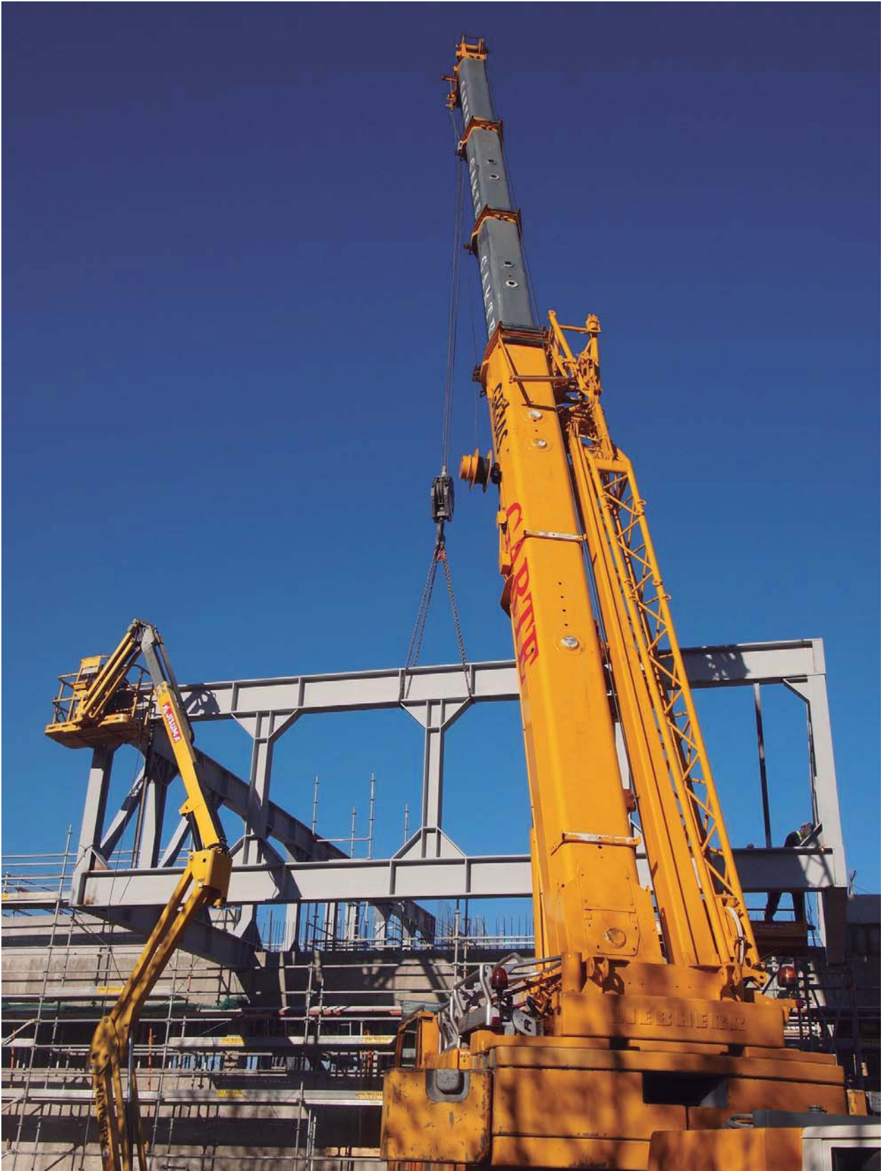
Fig. 30 – Colocación del tramo frontal de la estructura metálica del voladizo.
