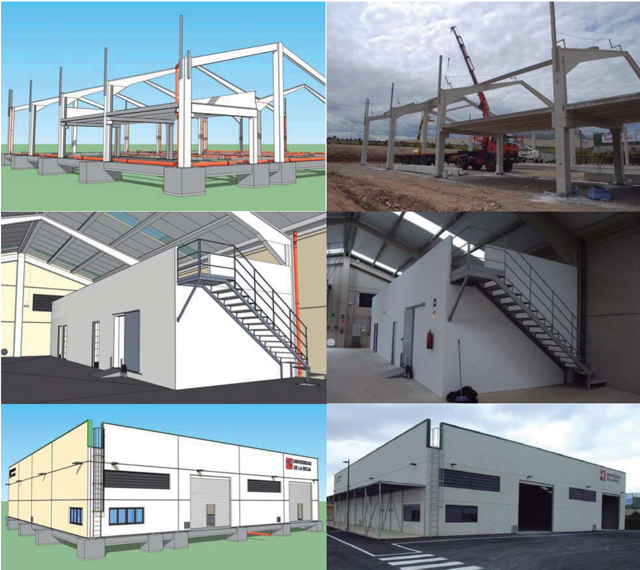
Fig. 2. 10- Comparación de alguna de las fases de la construcción del pabellón con el modelo 4D. Fuente (Vergara et al., 2014 85 )
