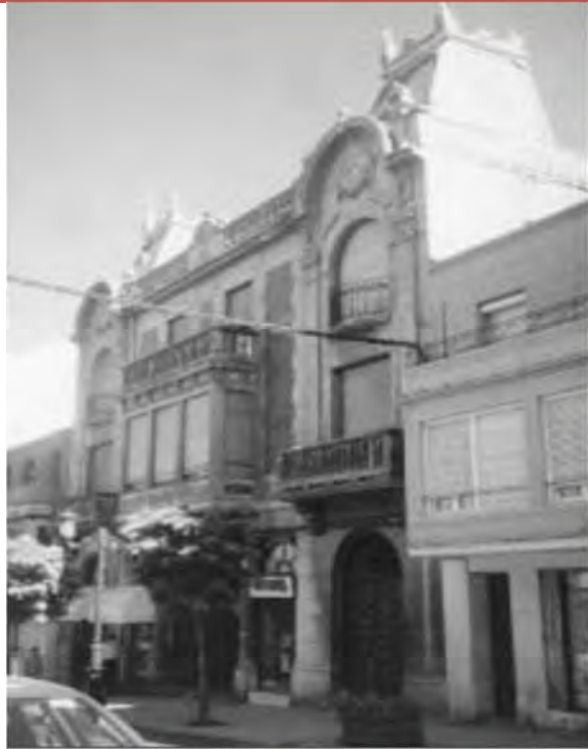
Figura 2. Calle Mártires nº 8. Estado actual.
