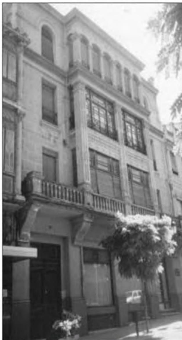
Figura 4. Calle Mártires nº 16. Estado actual.
