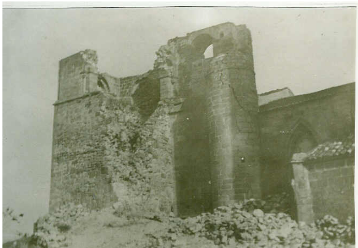
Derrumbe de la Torre Julia, 1920
