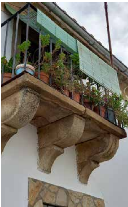
Balcón sobre ménsulas, calle del Cura.
