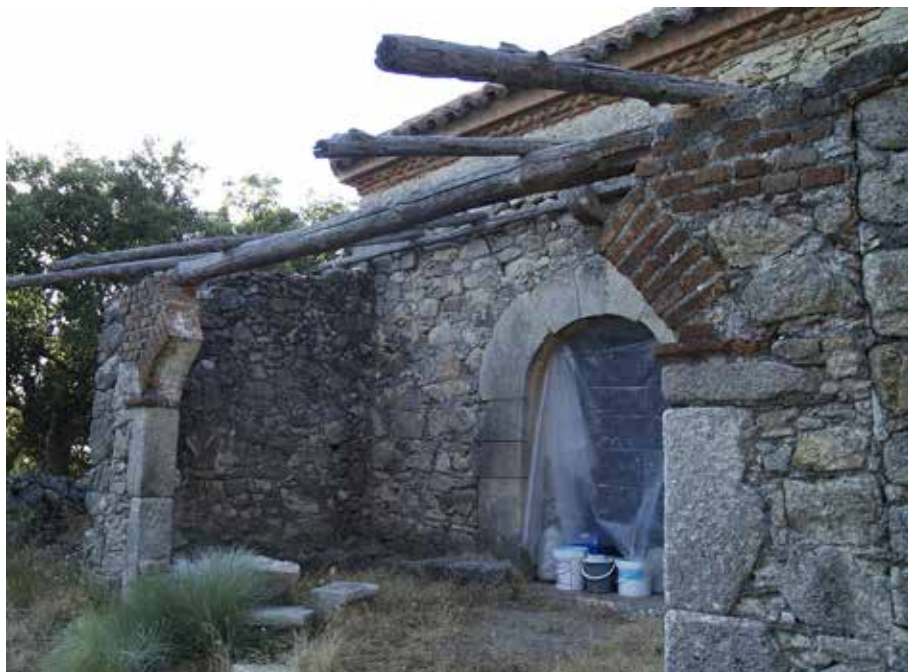
Ermita de Santa Bárbara, antes de su restauración.
