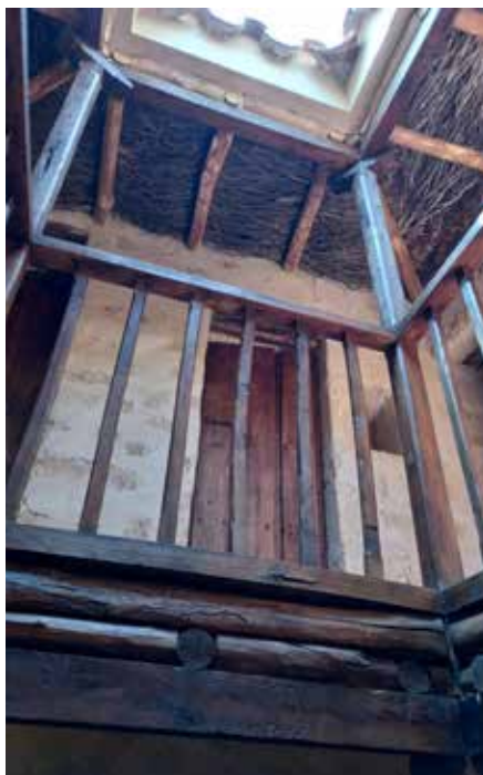
Piso superior del claustro.
