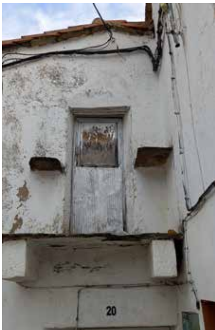
Ventana con alpoyatas, calle Real.
