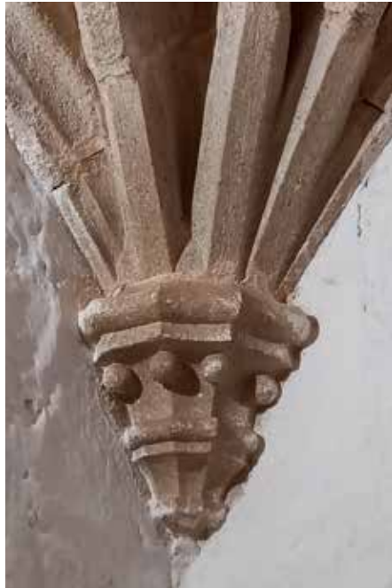
Detalle de la bóveda de crucería, pometeados.
