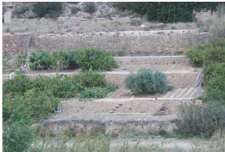
Terrazas de cultivo en ladera construidas con muros de piedra seca. Margen izquierda del río, próximo a la noria de La Ribera (Ojós) (2) .
