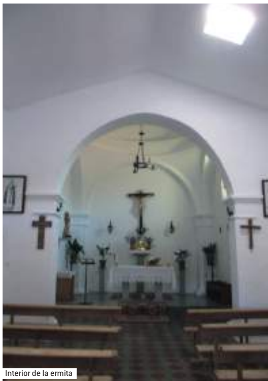
Presbiterio cubierto con cúpula semiesférica
