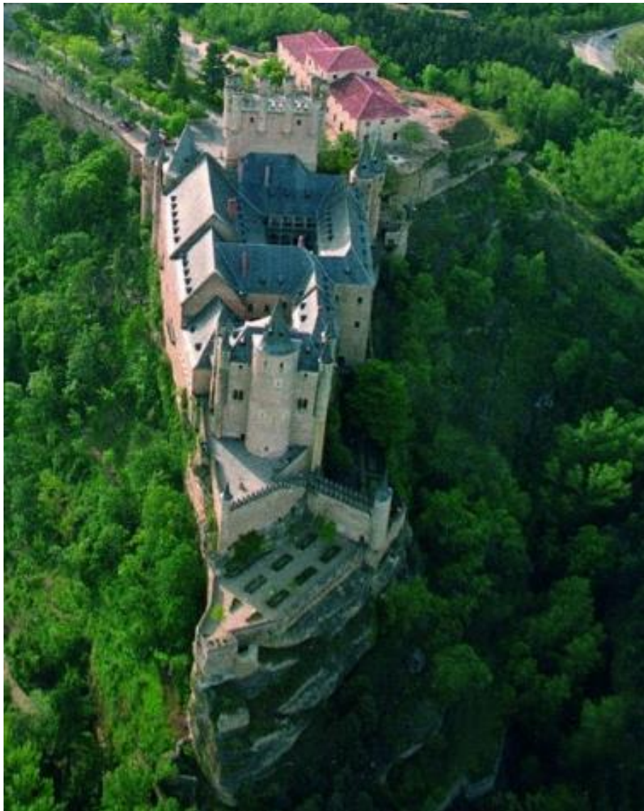
Alcázar de Segovia, baluartes aprovechando el terreno rocoso
