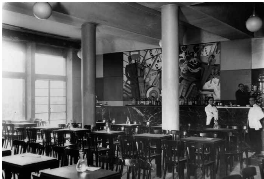
Fig. 61. Aspecto del interior del desaparecido café-restaurant Salduba (plaza de la Constitución, núms. 6-7, actual plaza de España), Zaragoza, hacia 1931 (Archivo BAU, Zaragoza).
