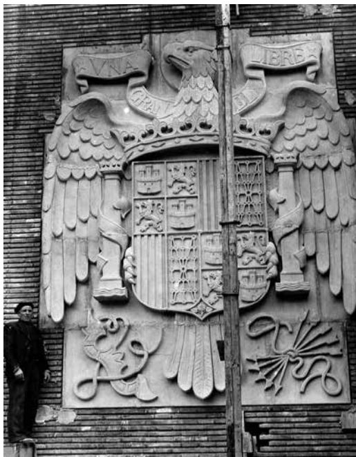
Fig. 55. Colocación del escudo sobre el balcón central de la fachada principal del edificio del Gobierno Civil, diciembre de 1952 (Archivo BAU, Zaragoza).
