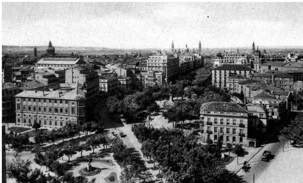
Fig. 10. Vista de las plazas de Paraíso y de Aragón, hacia mediados de la década de los cuarenta del siglo XX (Archivo Municipal de Zaragoza).
