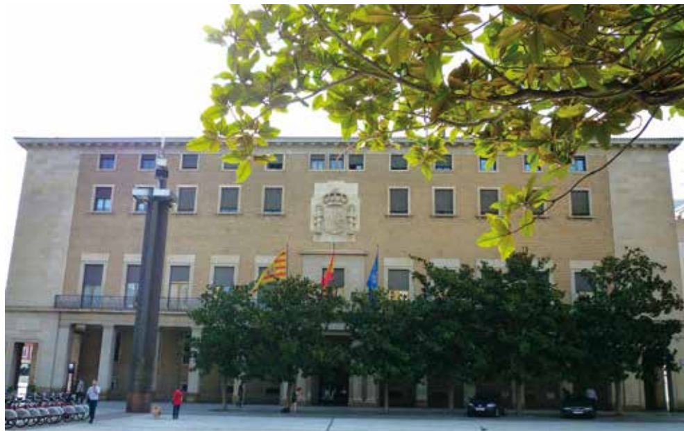
Fig. 96. Fachada principal del edificio de la Delegación del Gobierno en Aragón (fotografía: autora).
