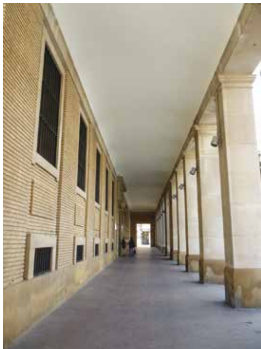
Fig. 95. Vista parcial de los porches de la fachada principal del edificio de la Delegación del Gobierno en Aragón (fotografía: autora).
